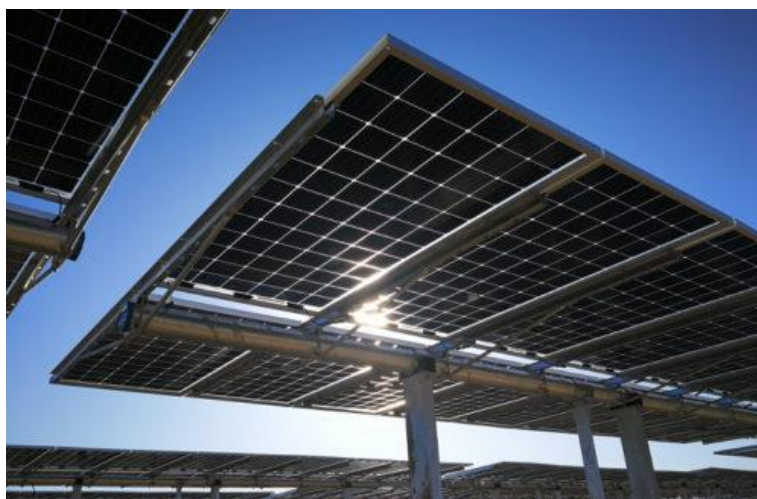
Figura 3.3: Esempio di struttura a tracker monoassiale
