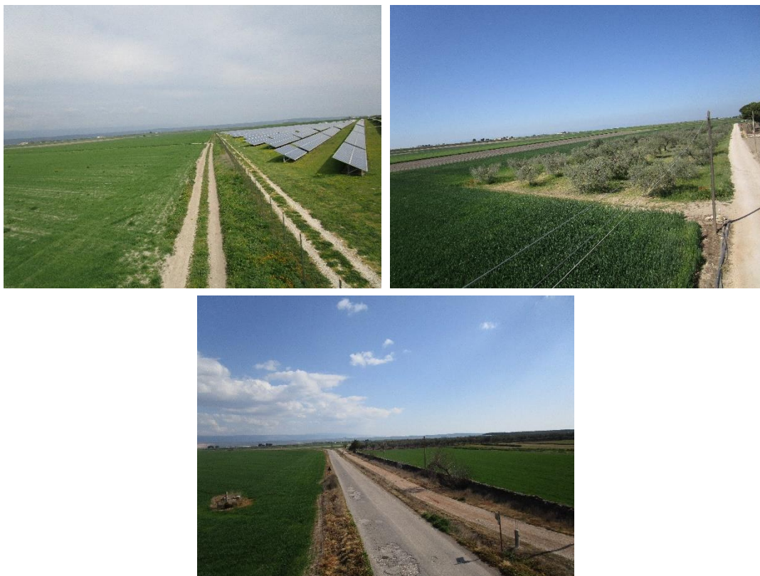
Figura 3.13: Immagini da sopralluogo (stato di fatto) effettuato nel mese di marzo 2022.
