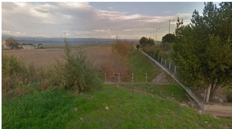
Figura 5.9: Interferenza P01 – sezione di valle dal ponte.
