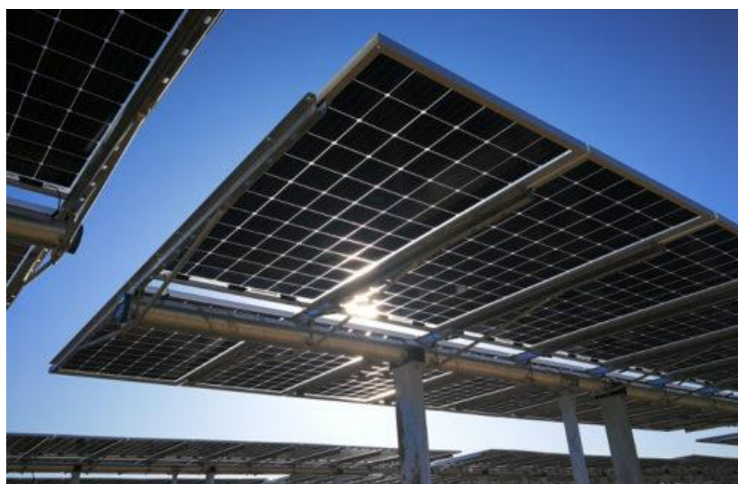
Figura 2.8 Esempio di struttura a tracker monoassiale
