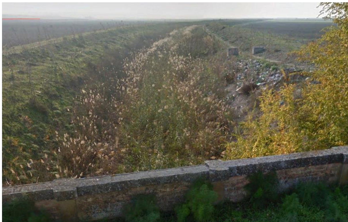
Figura 4.5: Torrente Candelaro in prossimità dell'area di intervento
