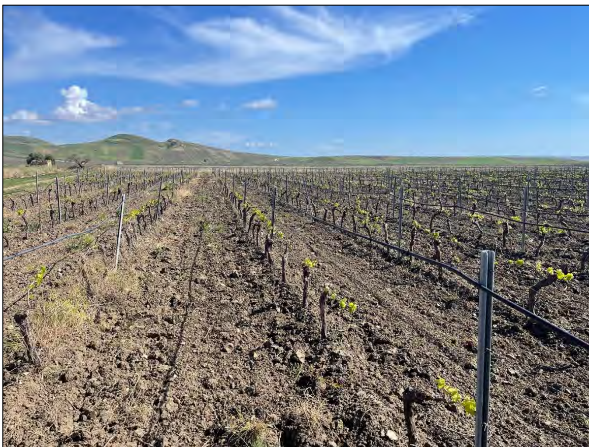
Foto 26 - Panoramica UR 08 (cavidotto interrato)
