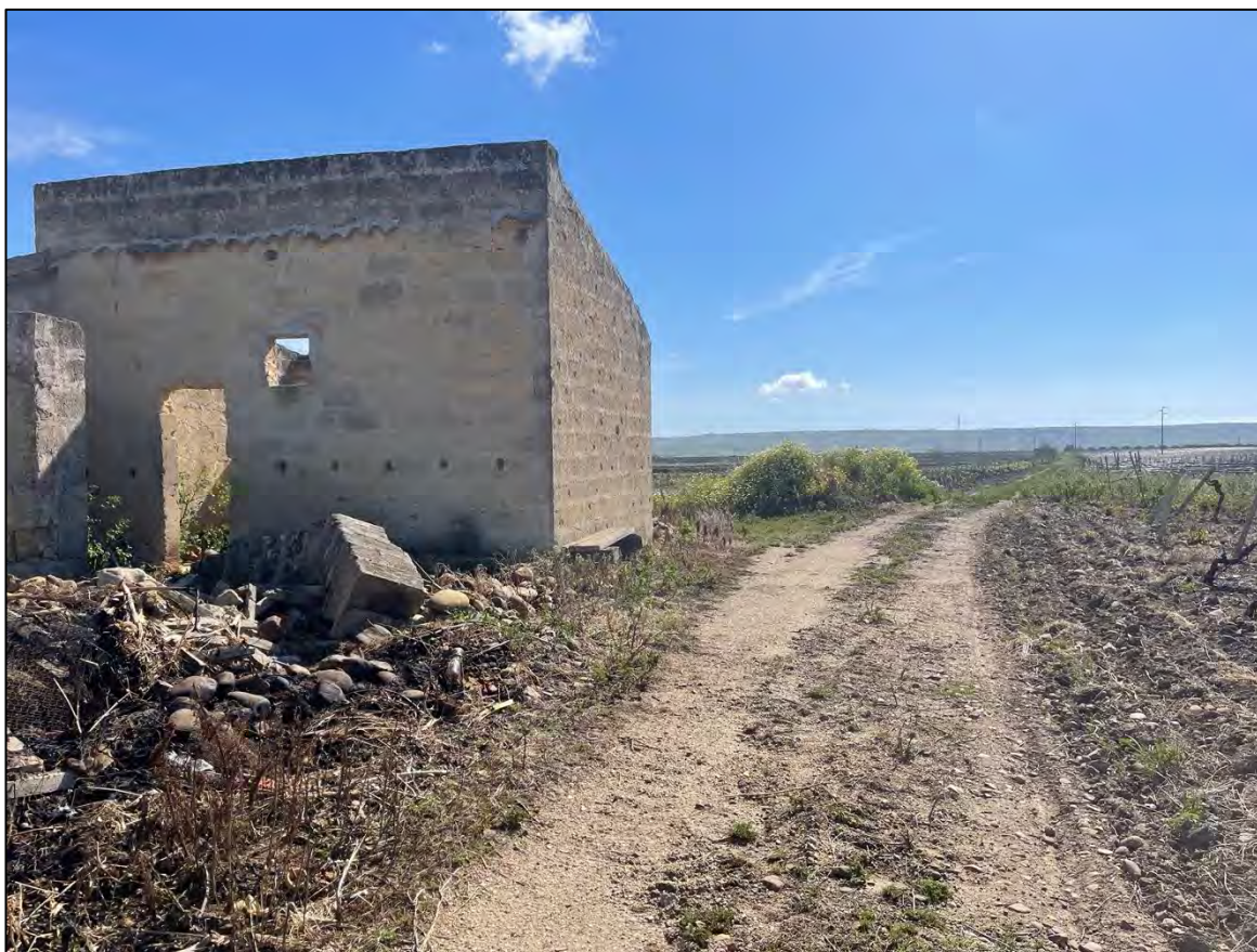
Foto 25 - Panoramica UR 08 (cavidotto interrato)
