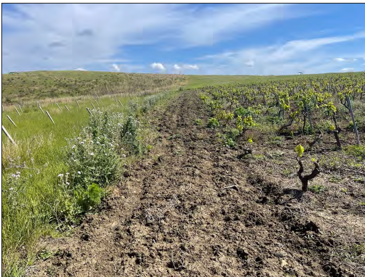
Foto 14 - Panoramica UR 05 (cavidotto interrato)
