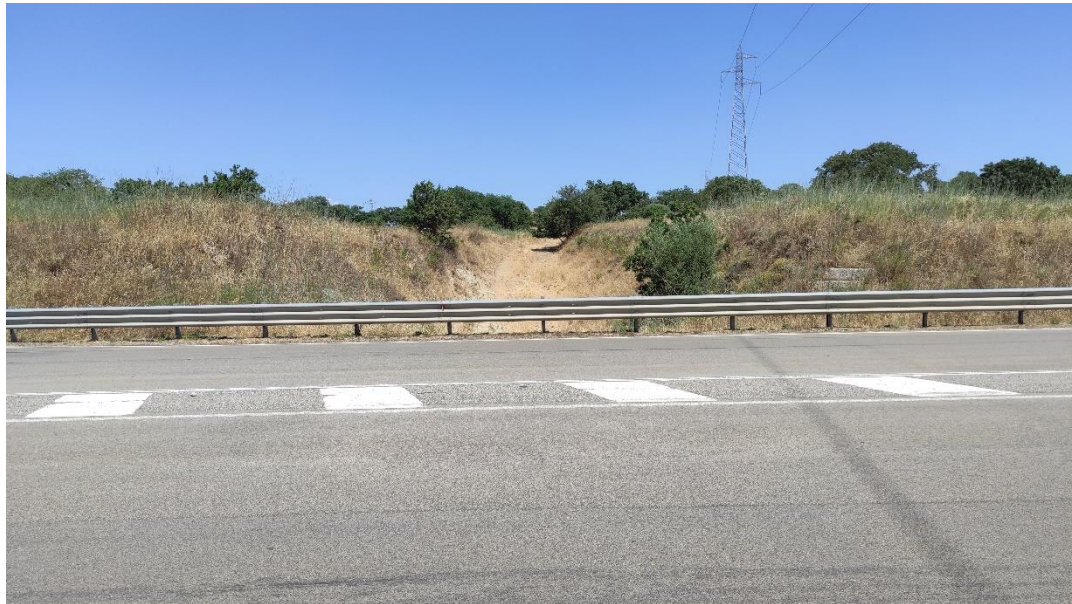
Attraversamento sede stradale su strada E840 con trivellazione
