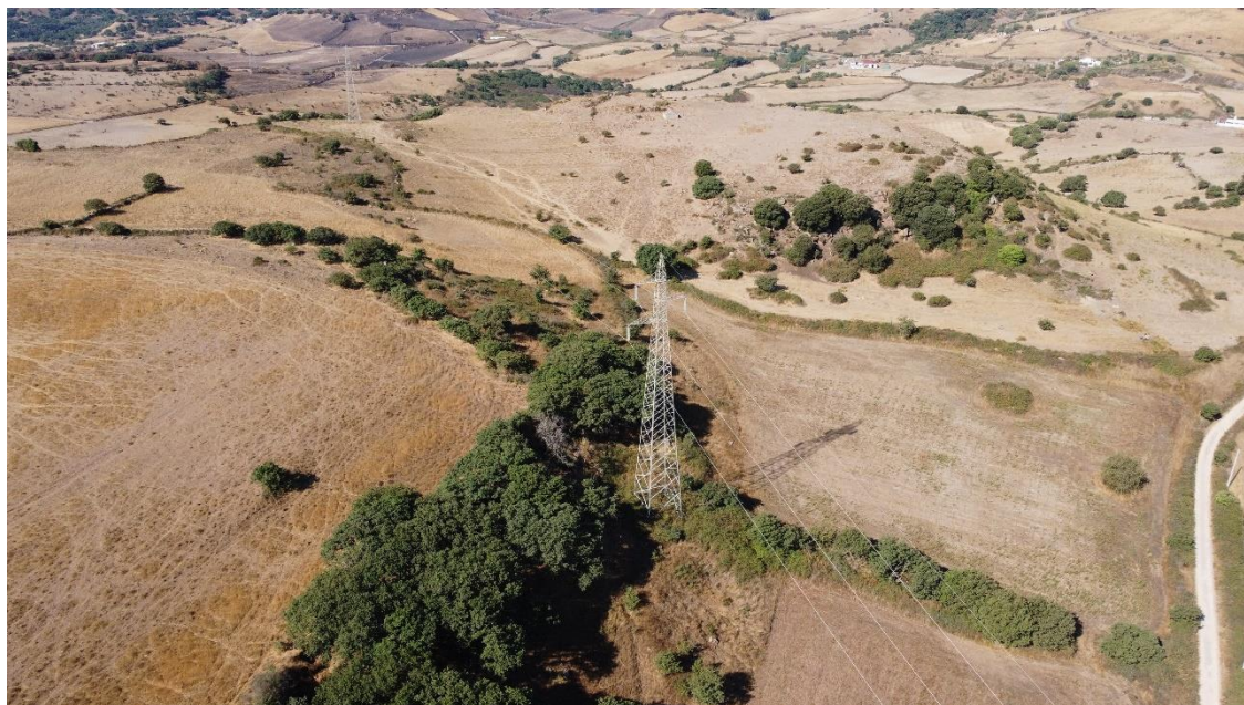
Zona con presenza della linea elettrica in AT
