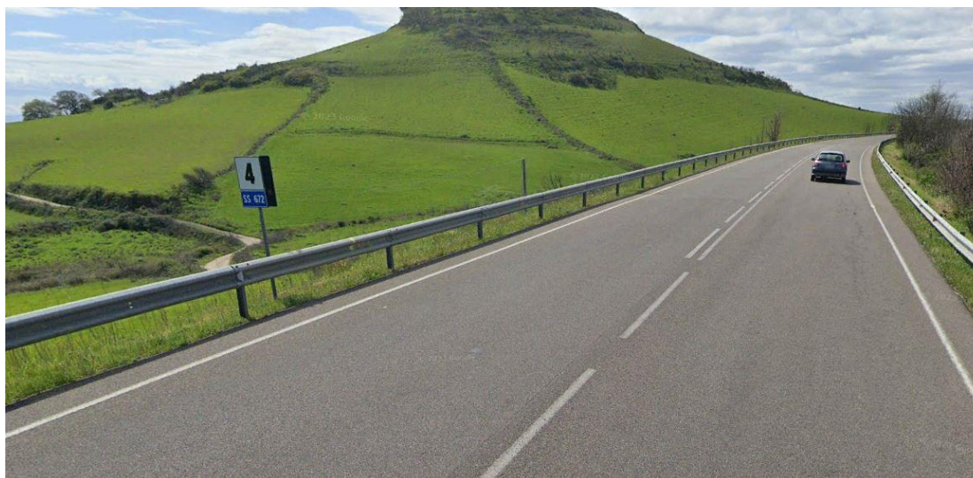
Attraversamento scatolare stradale su strada statale SS672 con trivellazione
