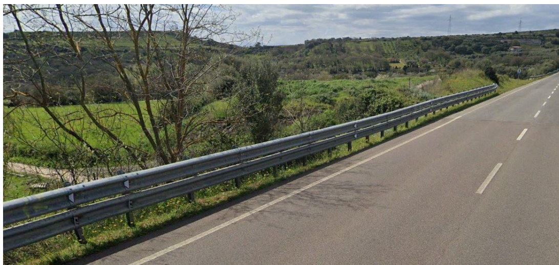
Attraversamento sede stradale su strada statale SS672 con trivellazione
