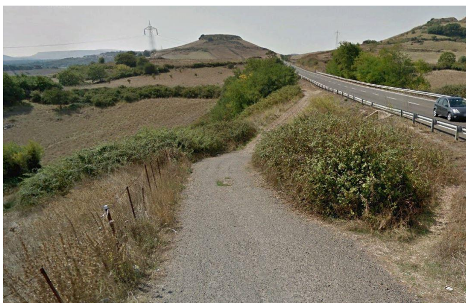
Attraversamento canale e sede stradale (strada comunale parallela alla SS672) con trivellazione
