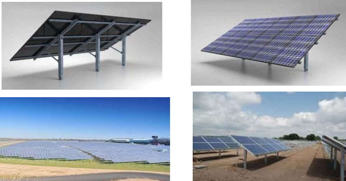
Fig. 3 – Immagini reali della struttura di supporto moduli
