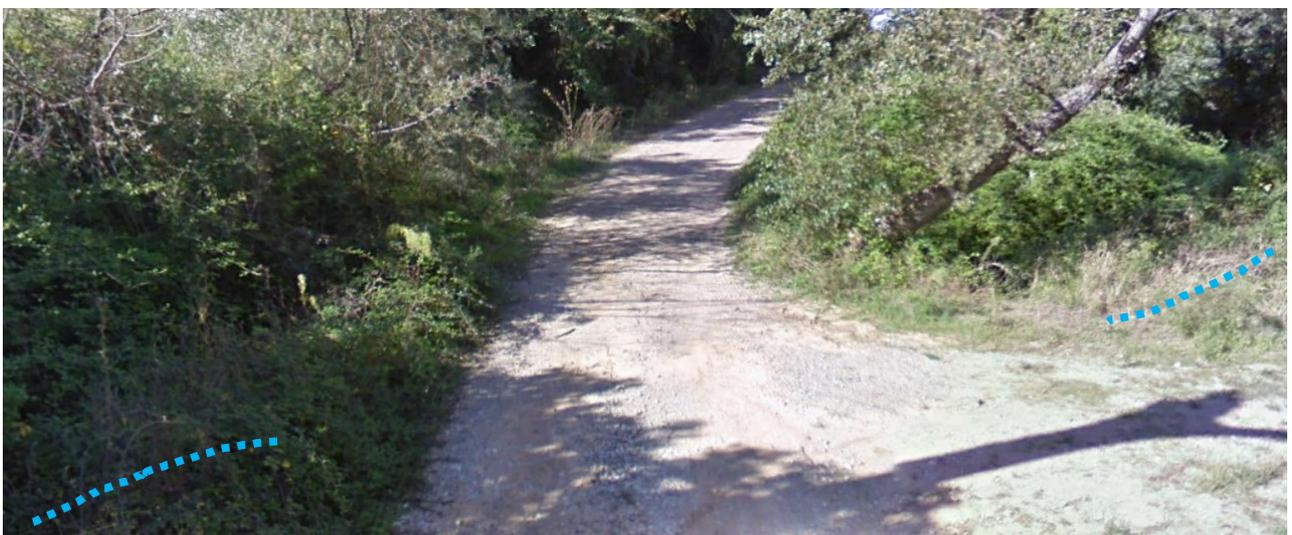
Figura 2-4: il passaggio in corrispondenza del piccolo ponticello. In ciano, l'indicazione dell'asse del Mannara, oltre 1,5 m al di sotto del piano stradale.
