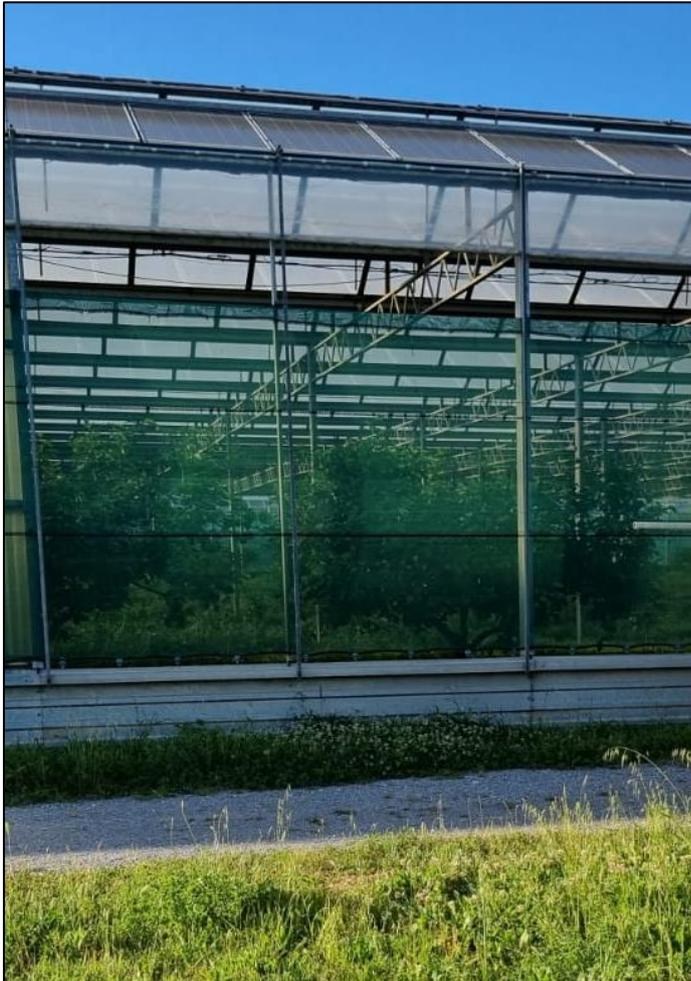
*Foto 7: Foto delle serre agrivoltaiche dell'impianto di Scalea (CS), all'interno delle quali si coltivano agrumi (cedri e limoni). Si evidenzia la tipologia di rete frangivento che verrà utilizzata per i tracker dell'impianto agrivoltaico di Su Barroccu.*
