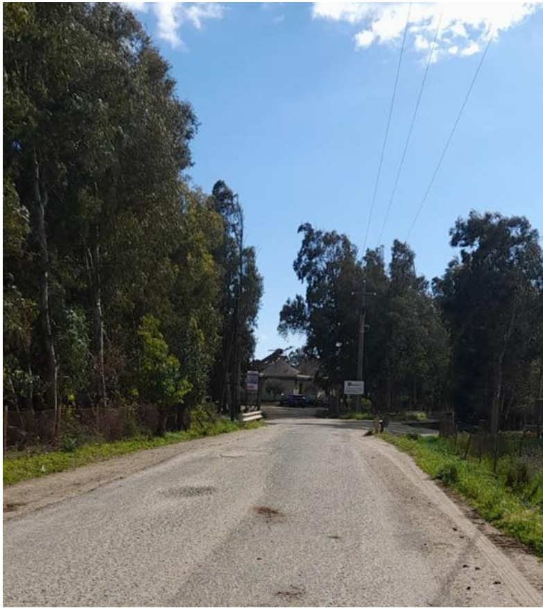
Figura 5: Restringimento strada a 4,7 m
