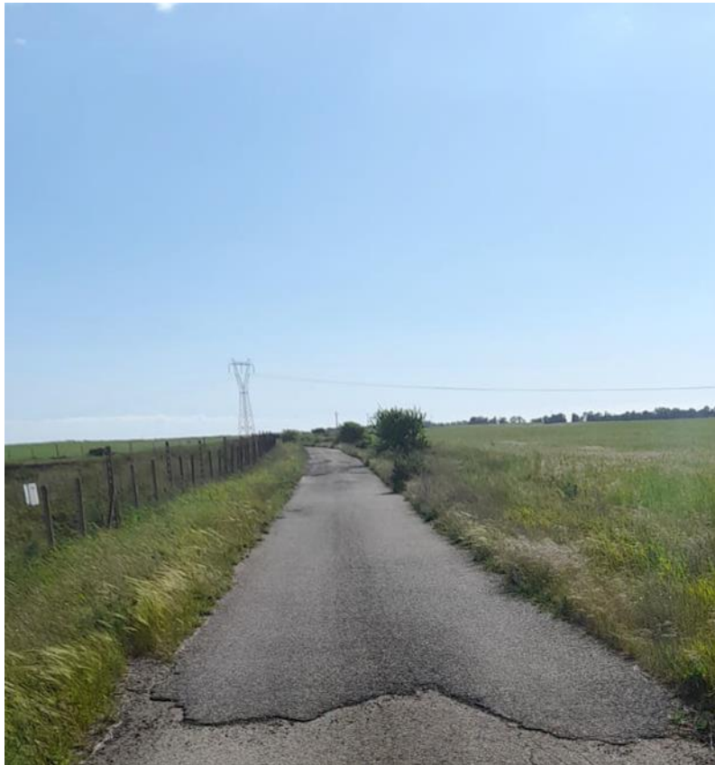
Figura 6: Tratto di strada terminale per accedere alla SE
