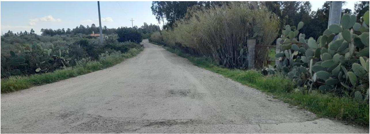
Figura 4: Imbocco strada larghezza 7,7 m
