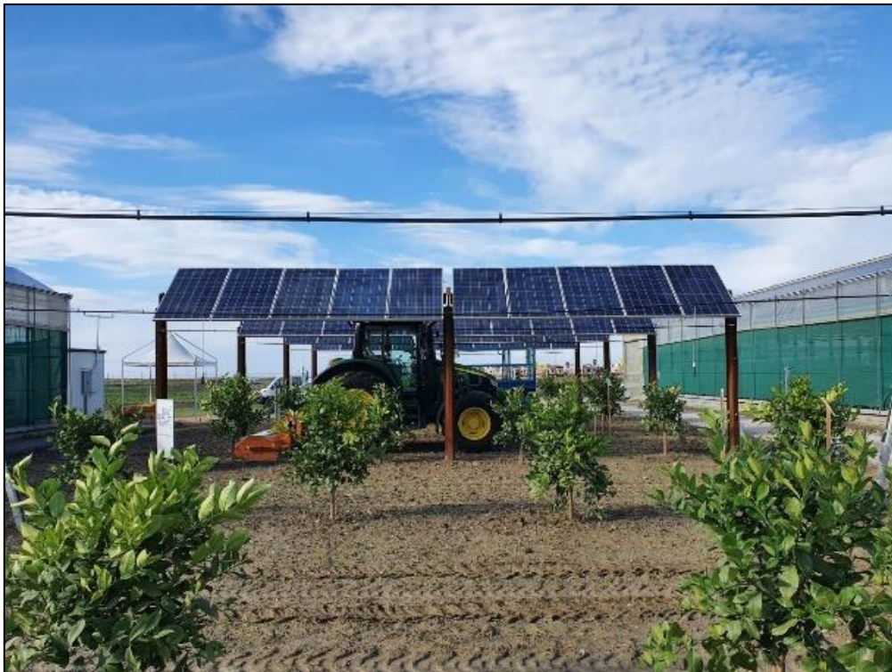
Figura 45: Foto di un impianto dimostrativo realizzato nel complesso agrivoltaico di Scalea (CS) gestito dal Consorzio Le Greenhouse.
