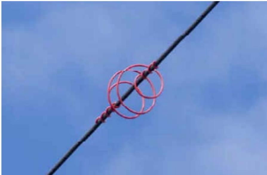
**Figura 4 – Spirale colorata in plastica per la segnalazione dei conduttori**
