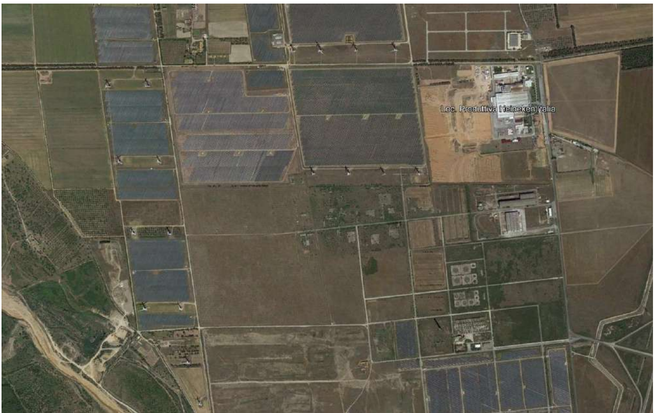
Fig. 30-31 Macchiareddu (S/W), Comune di Assemini 2015-2022
