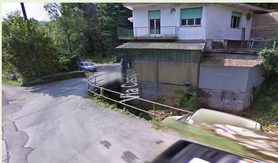
Figura 3 – Ponte carrabile idraulicamente insufficiente per TR 50 anni
