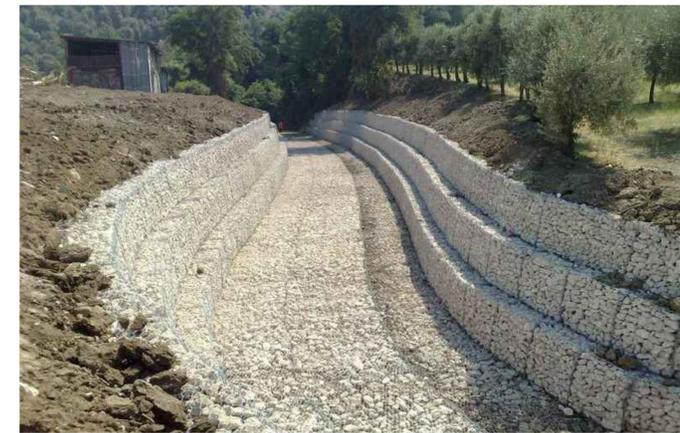
Sistemazione dell'alveo di un torrente con tre ordini di gabbioni riempiti in spaccato di cava (immagine di riferimento)
