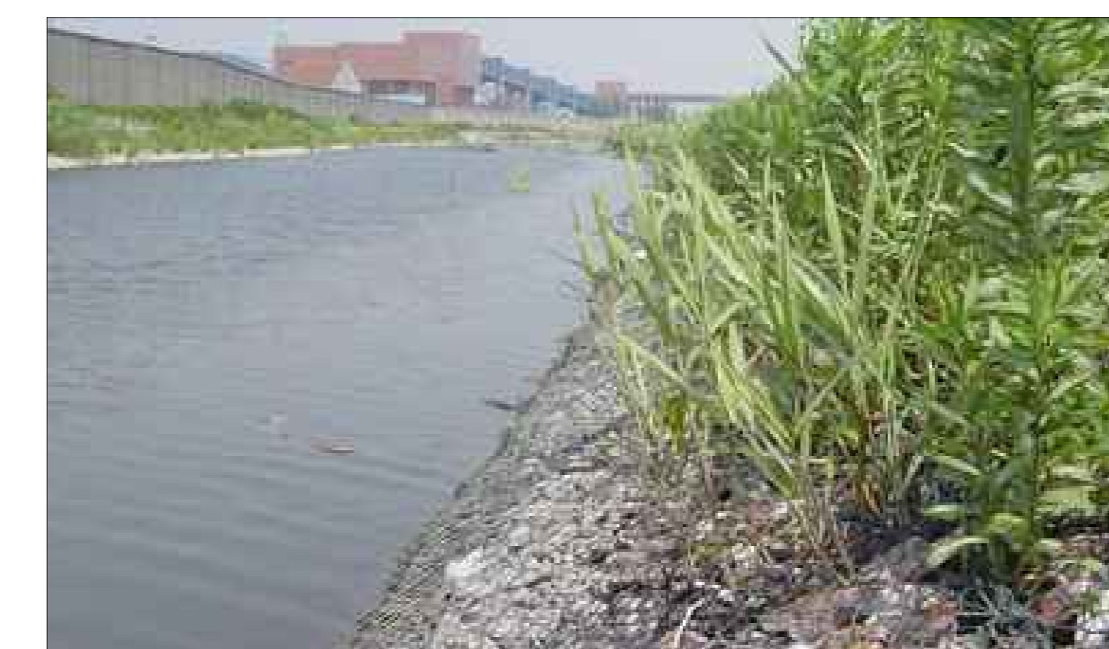
Sistemazioni dell'alveo di un torrente con gabbioni riempiti in pietra naturale e rinverdimento (immagini di riferimento)
