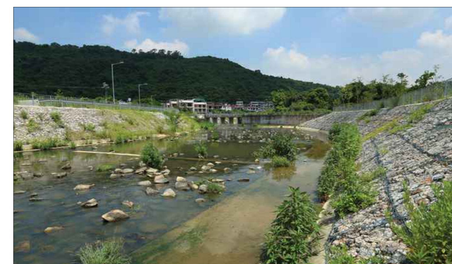
Sistemazioni dell'alveo di un torrente con gabbioni riempiti in pietra naturale e rinverdimento (immagini di riferimento)
