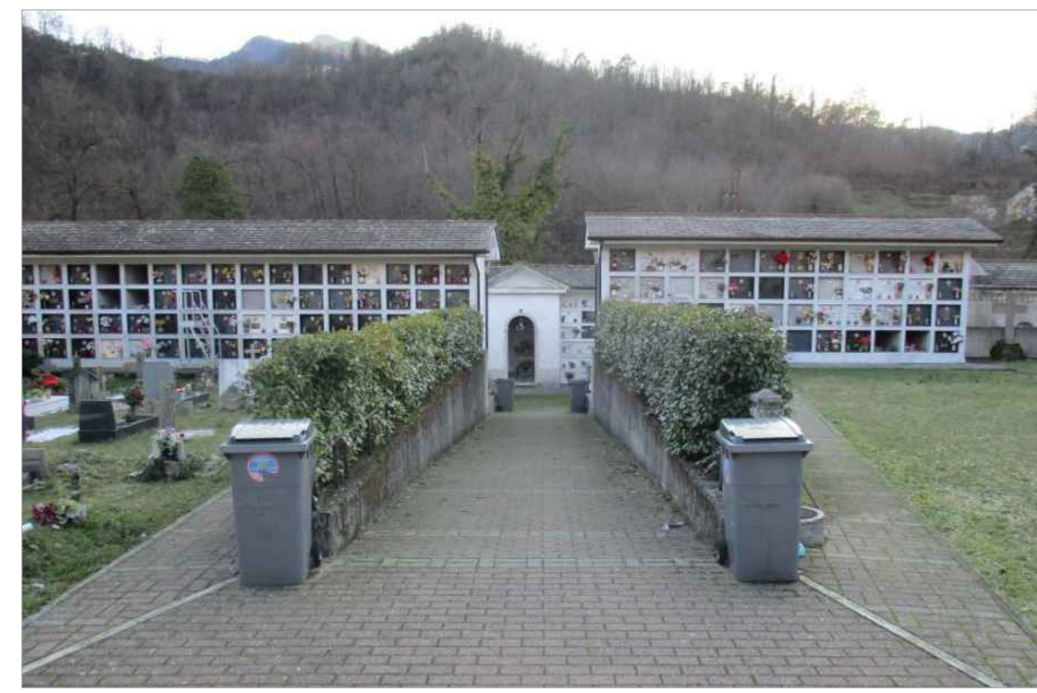
Cimitero di Ferrada - Stato di fatto attuale degli spazi interni.
