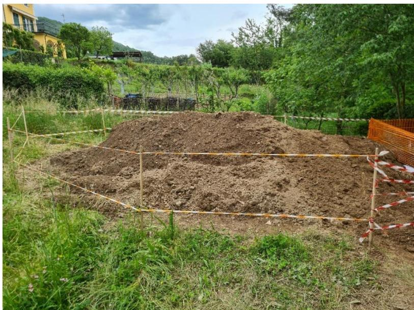
*Figura 5-14. Recinzione dell'area di cantiere con la terra di risulta.*
