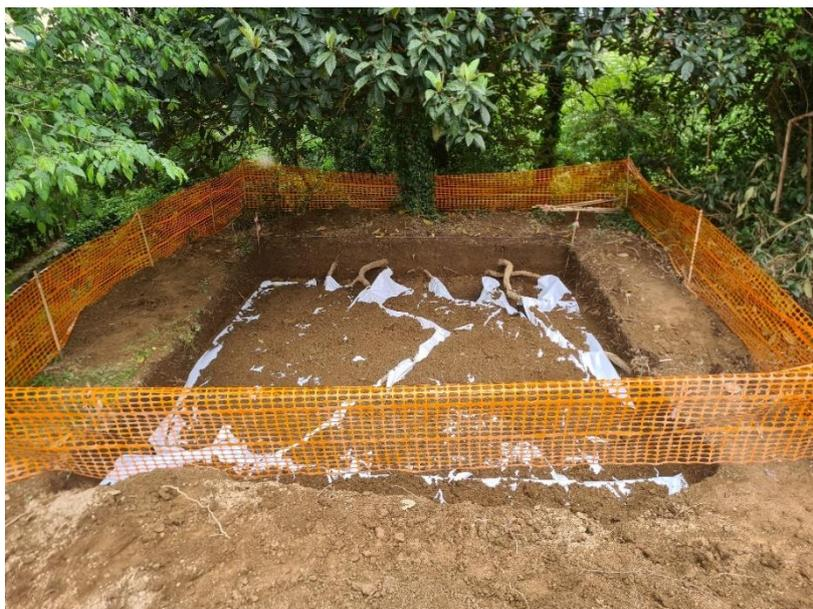
Figura 5-12. Ricopertura dell'area con geotessuto.
