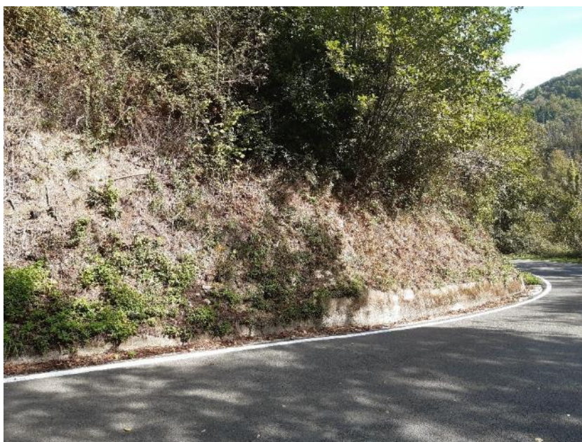
Foto 2 – Muretto in cls e cordolo sul lato di monte della SP22. Sul versante è presente vegetazione arborea
