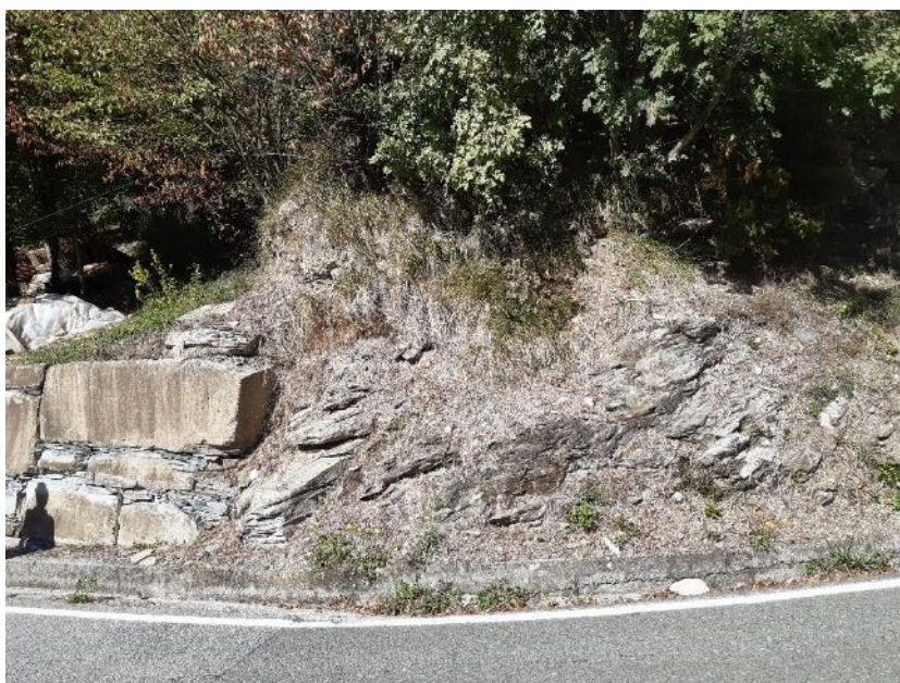
Foto 7 – Affioramento di Ardesie a monte strada sul lato destro del muro in pietra.
