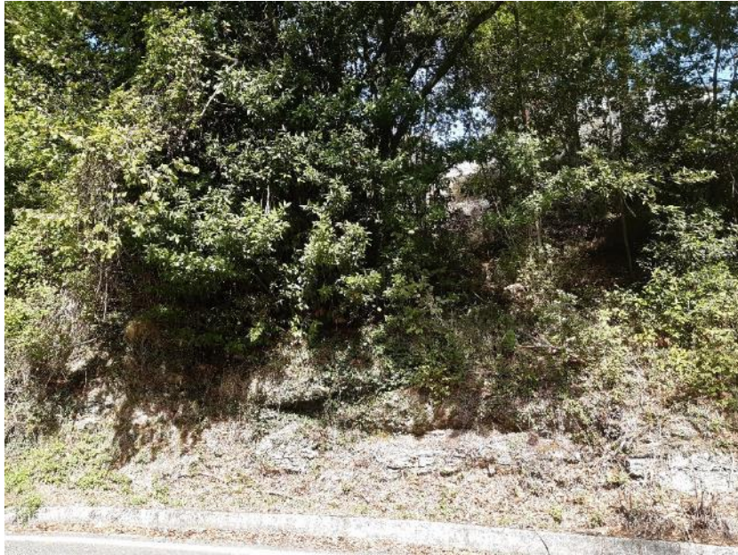
Foto 4 – Affioramento di ardesie a destra del muro in blocchi
