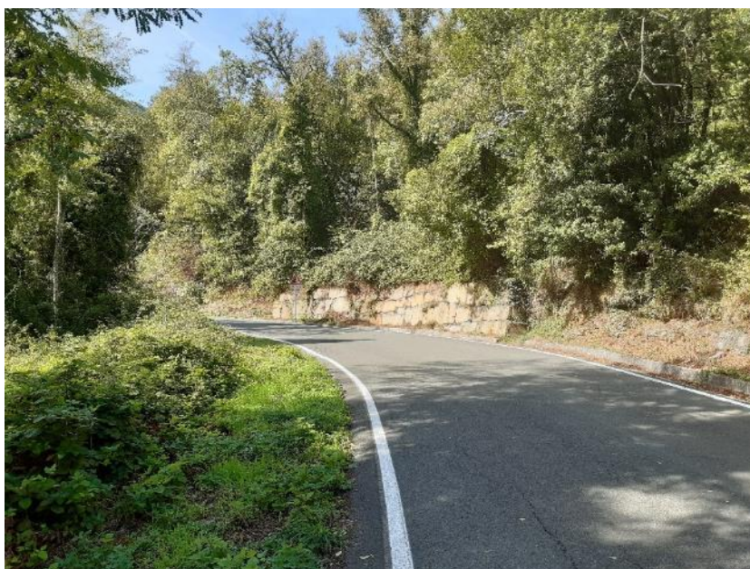
Foto 3 – Muro in blocchi con vegetazione arbustiva e rovi
