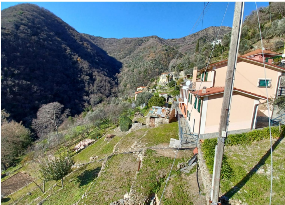
Figura 3-8 – Arbocco', versante sopra il torrente Foggia
