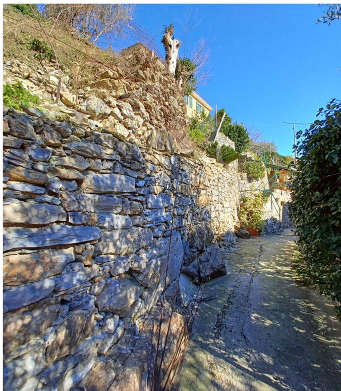
Figura 3-9 – Arbocco', stradina di collegamento verso l'impluvio del rio Serra
