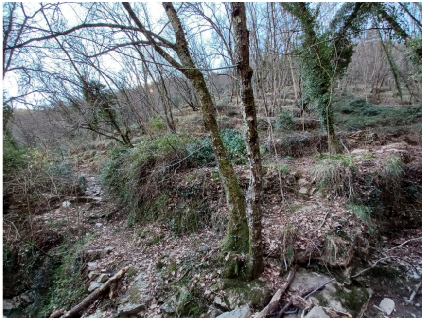
Figura 3-13 – Versante dell'imbocco nord della galleria Caravaggio
