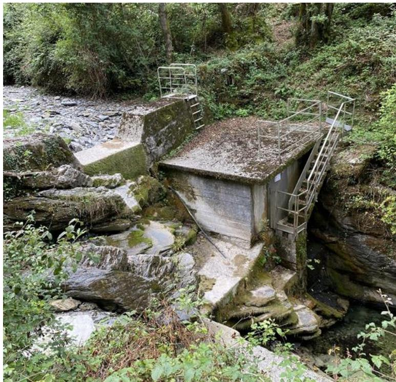
Figura 2-3 – Bottino di presa S512 e briglia che sottende il materiale detritico che costituisce un piccolo invaso idrico (8 settembre 2022).
