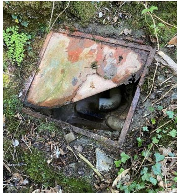
Figura 2-12 – Bottino di presa della S530 (immagine a sinistra) completamente ricoperto da concrezioni, il tubo metallico si interrompe dopo pochi metri. A destra la captazione della sorgente S531.
