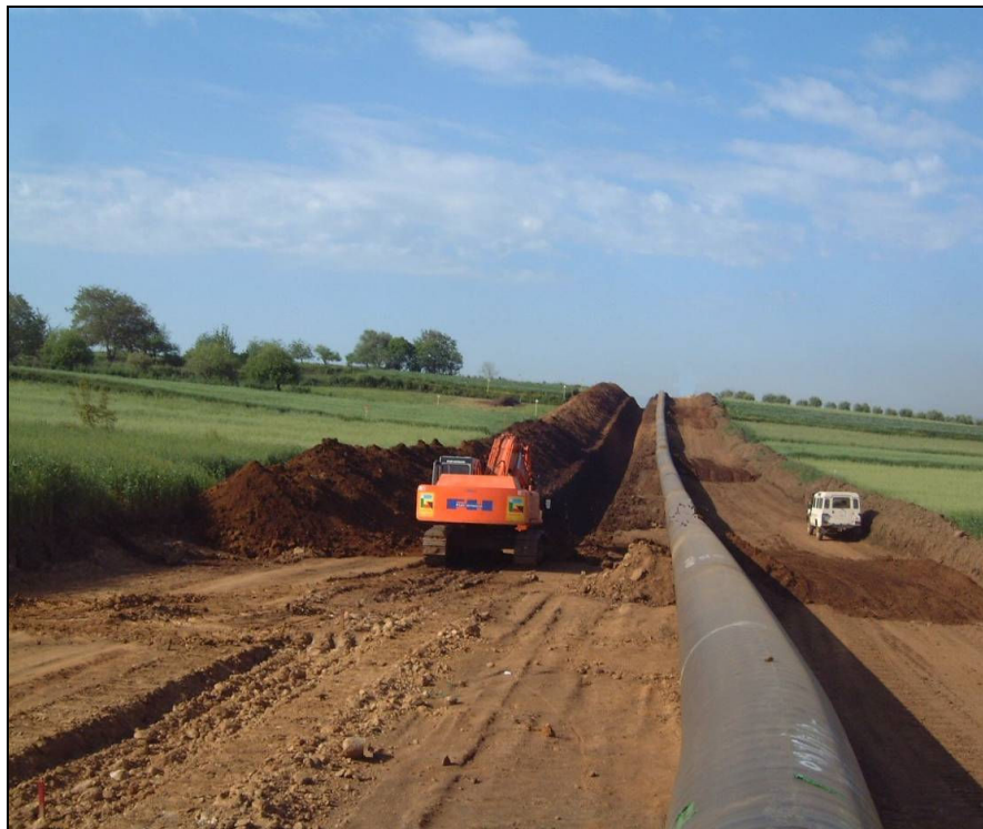
Foto 3-F: Scavo della trincea
