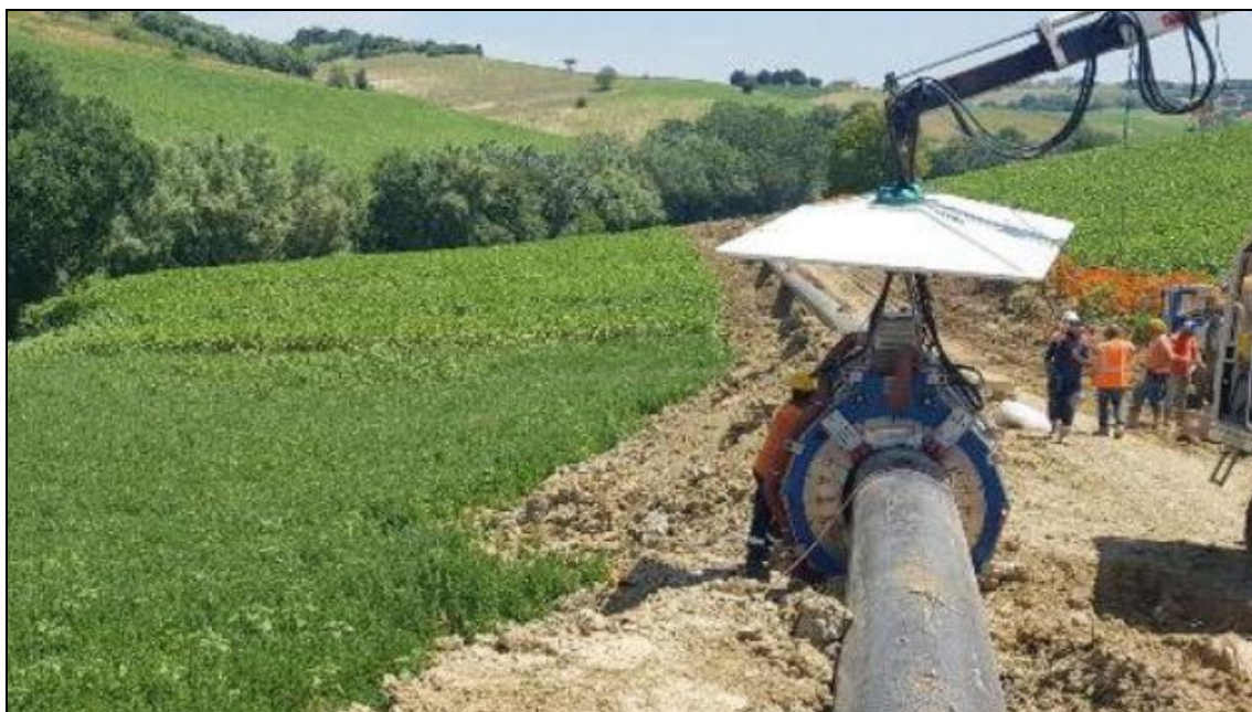
Foto 3-E: Esempio di saldatura automatica
