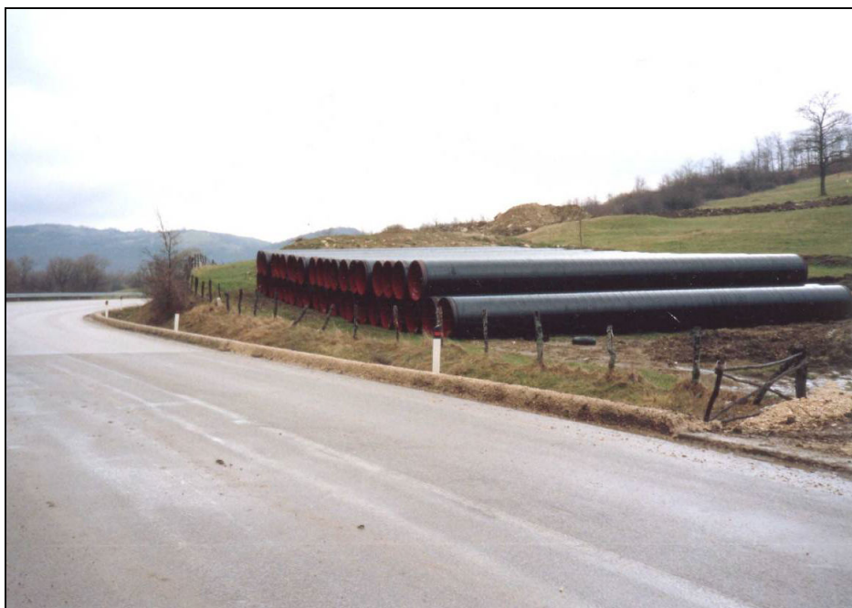
Foto 3-A: Esempio di piazzola di accatastamento tubazioni
