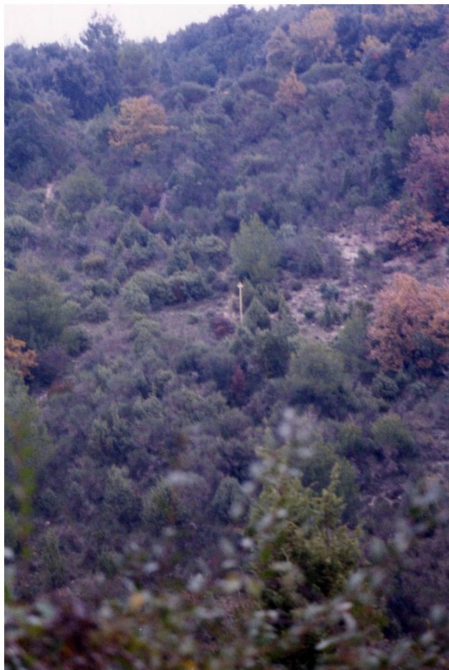
Foto 3–L: Lavori di costruzione terminati circa 30 anni fa - il tracciato del metanodotto è difficilmente individuabile. La vegetazione ha ormai ricoperto tutto il versante.
