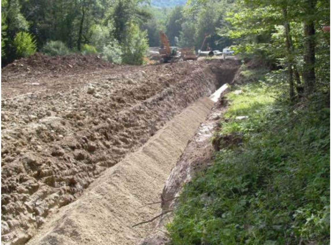
Foto 3-I: Rinterro della condotta
