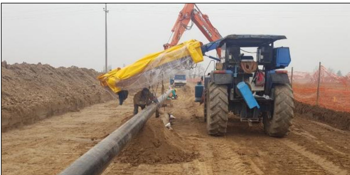
Foto 3-D: Esempio di saldatura manuale
