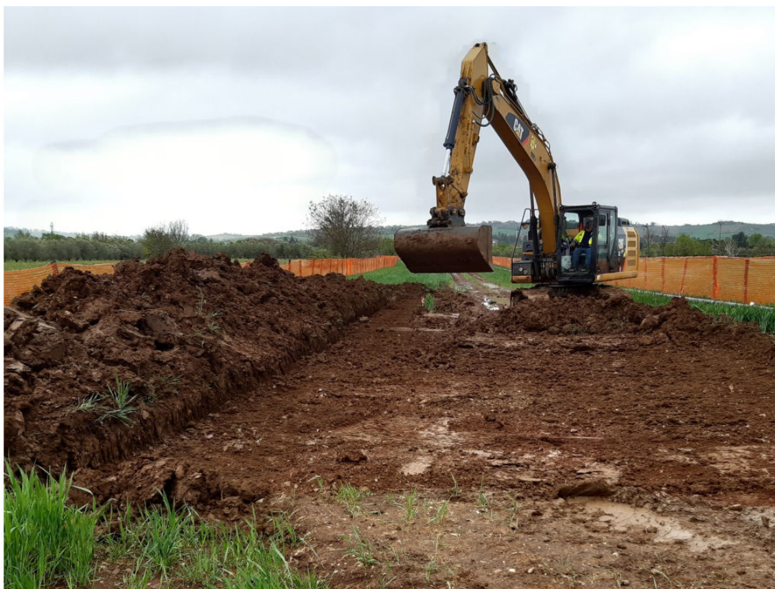
Foto 3-B: Apertura dell'area di passaggio
