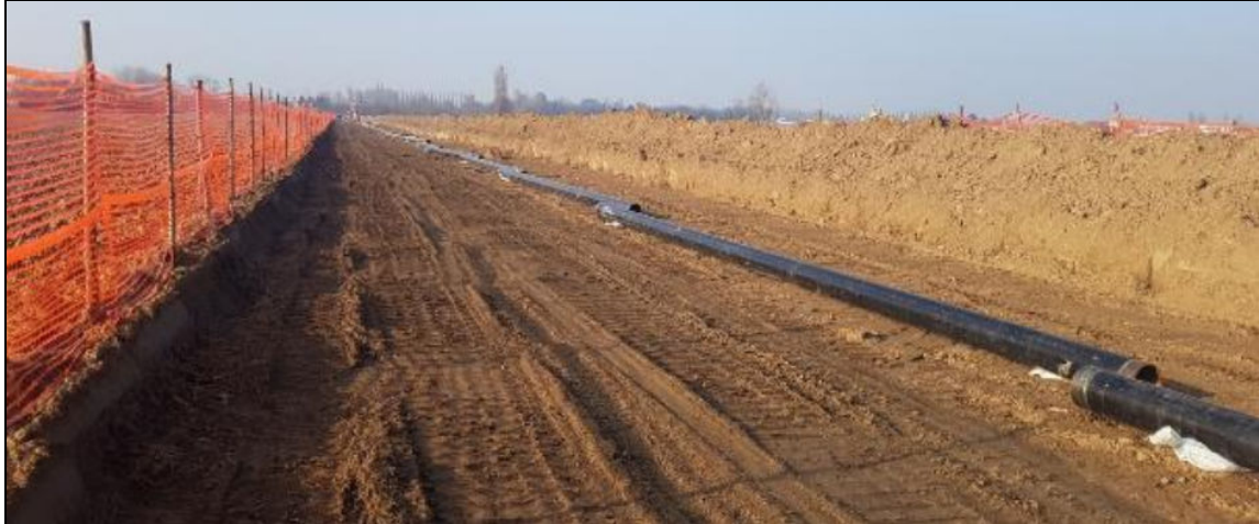
Foto 3-C: Sfilamento tubazioni
