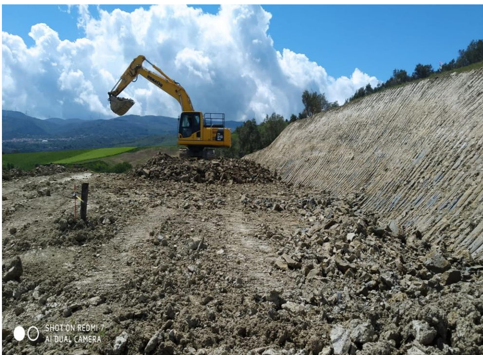
Foto 2 – Realizzazione piazzola e fondazione
