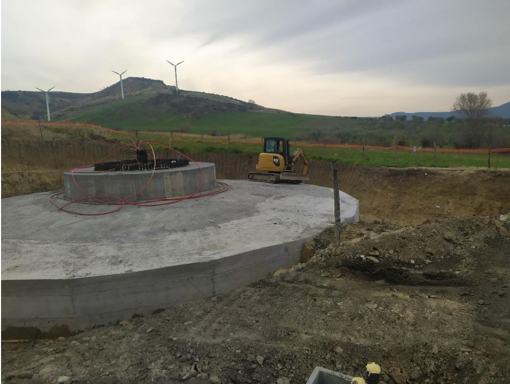
Foto 3 – Plinto di fondazione realizzato
