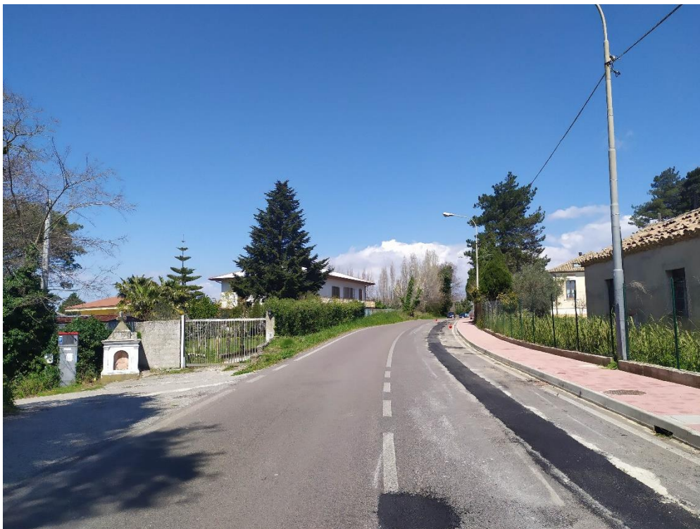
Foto 6 – Ripristino manto stradale dopo posa corrugato su SP172
