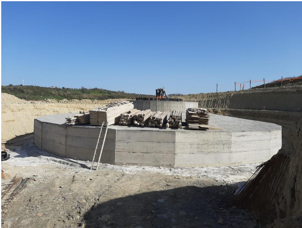
Foto 3 – Disarmo plinto di fondazione e colletto
