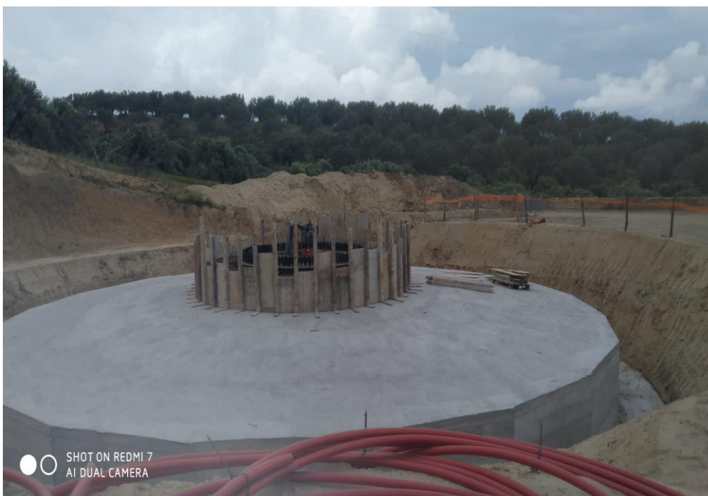
Foto 2 – Plinto di fondazione realizzato
