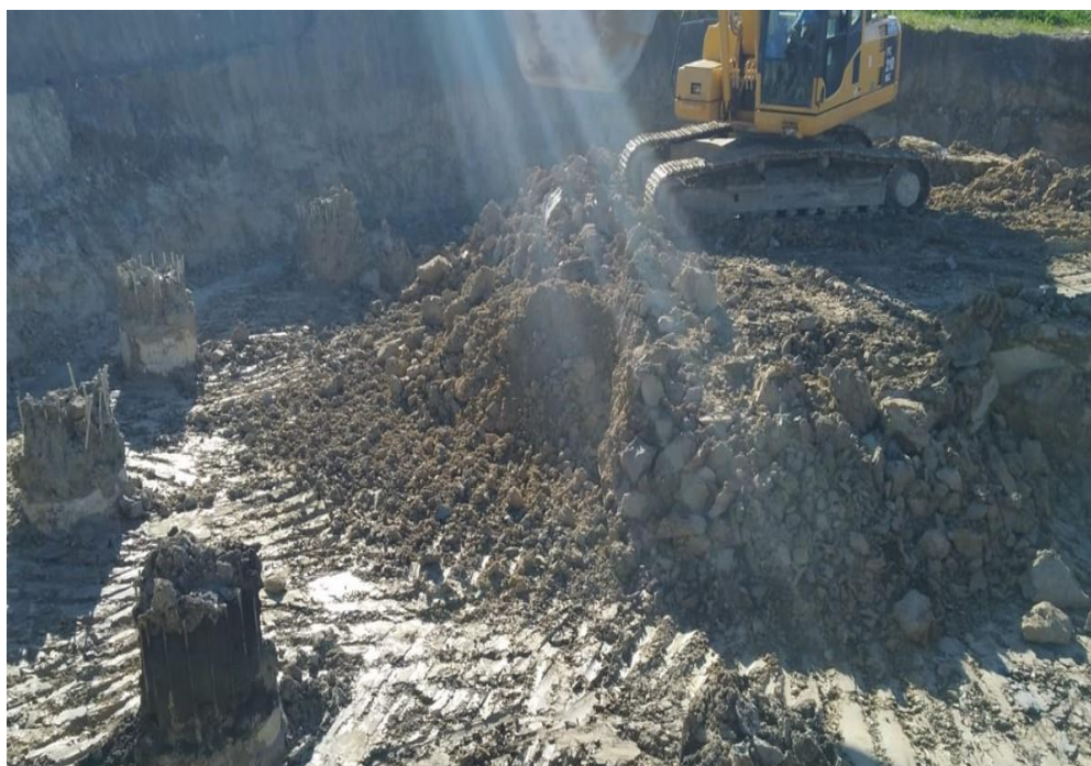
Foto 2 – Scapitozzatura pali di fondazione e scavo quota imposta fondazione
