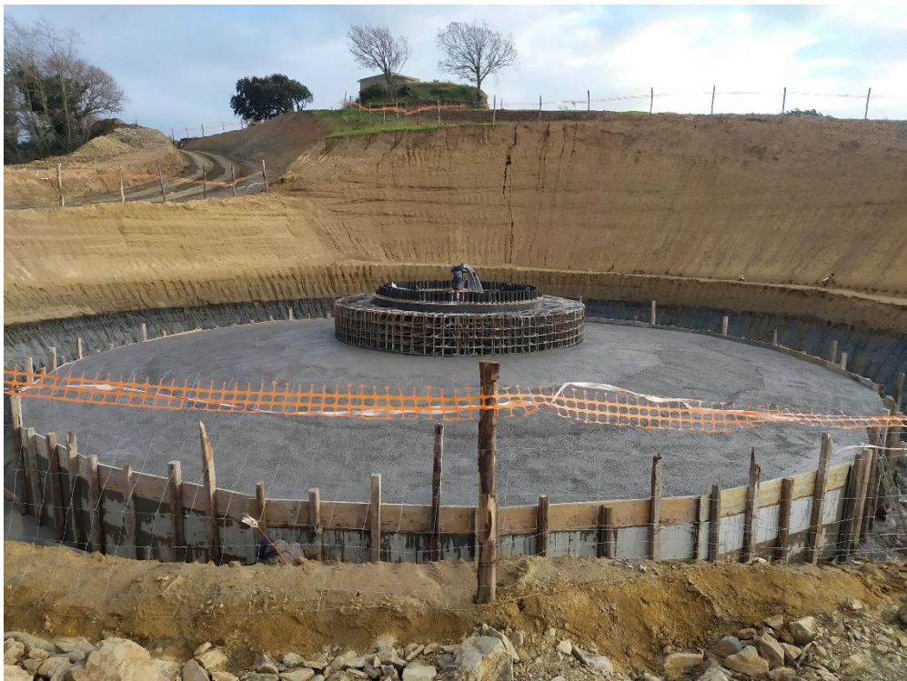
Foto 3 – Plinto di fondazione gettato e armato
