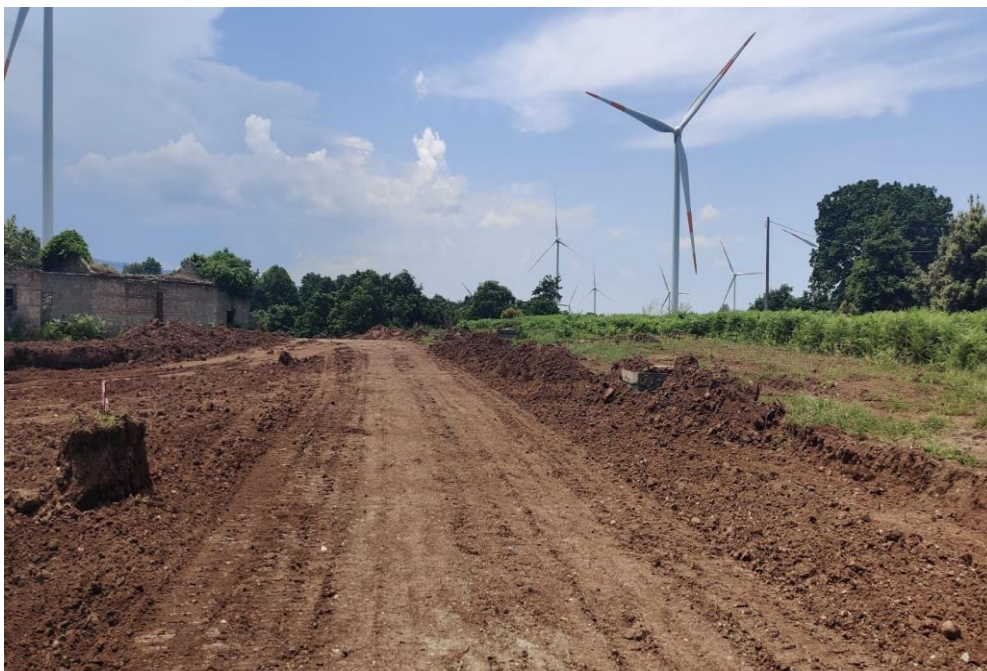
Foto 1 – Sbancamento quota imposta fondazione edificio di controllo
