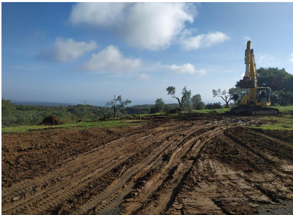
Foto 1 – Scotico superficiale area piazzola
