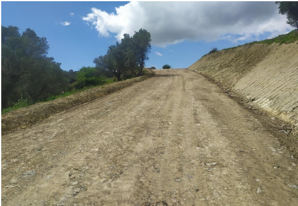
Foto 1 – Realizzazione strada di accesso
