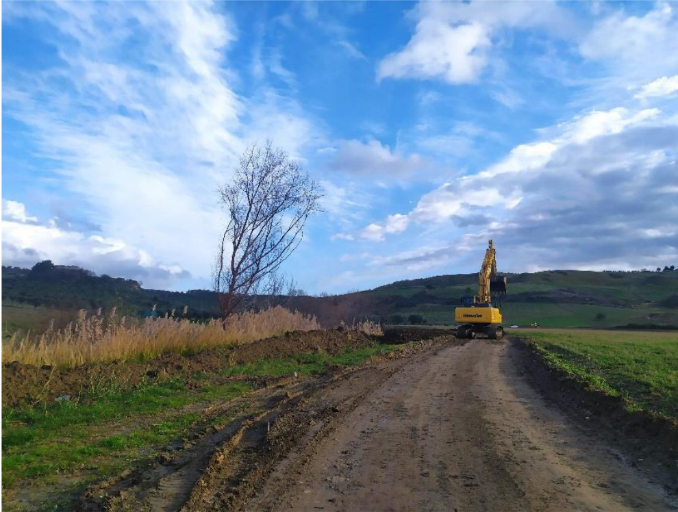
Foto 1 - Sistemazione strada esistente accesso
