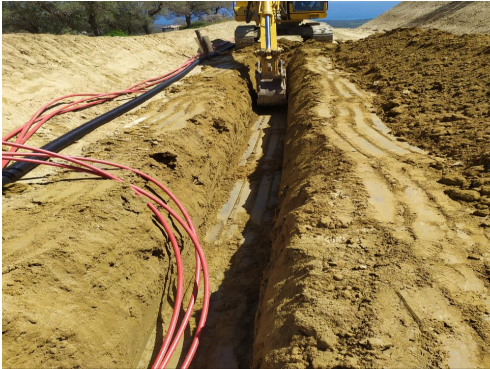
Foto 2 – Posa cavo su strada di accesso WTG A42
