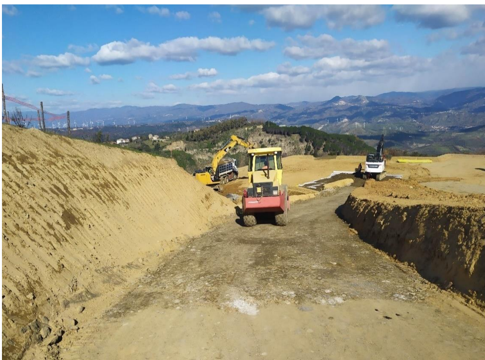
Foto 1 – Realizzazione strada di accesso
