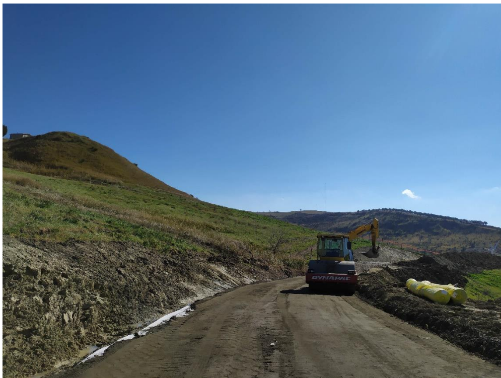
Foto 1 – Realizzazione strada di accesso
