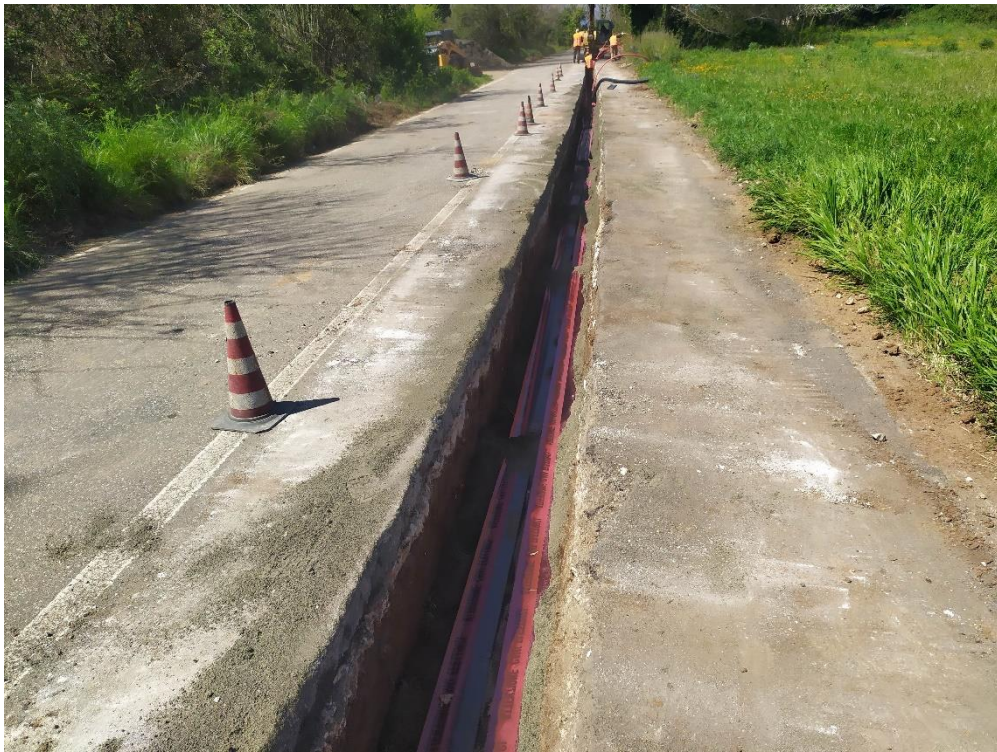
Foto 3 – Posa cavo su SP49
