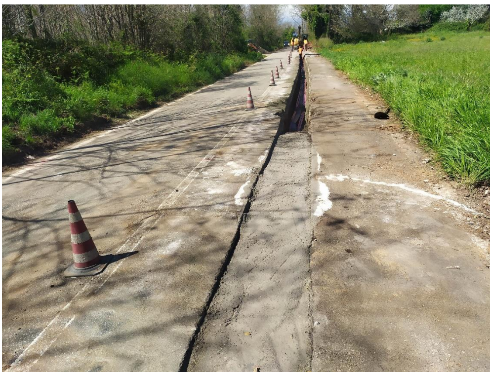
Foto 4 – Operazioni di ripristino manto stradale dopo posa cavo su SP49
