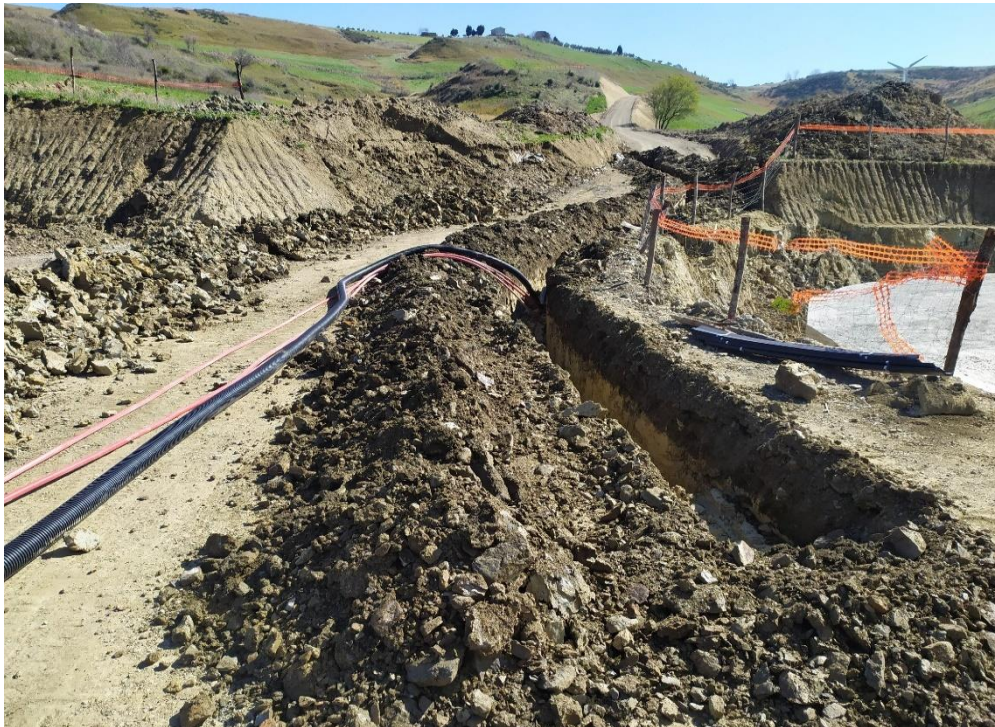
Foto 1 – Posa cavo su strada di collegamento WTG A29-A30
