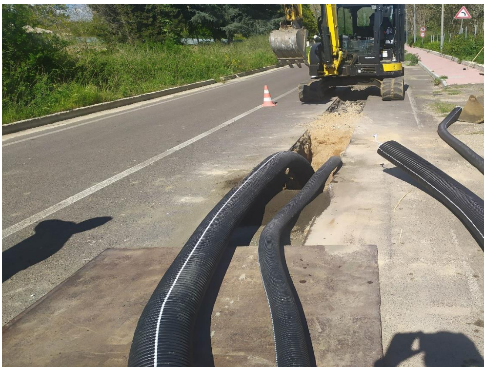
Foto 5 – Posa corrugato su SP172
