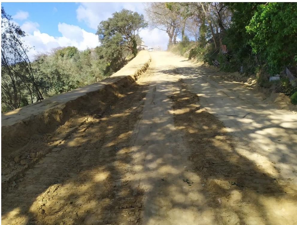
Foto 1 – Adeguamento strada di accesso esistente
