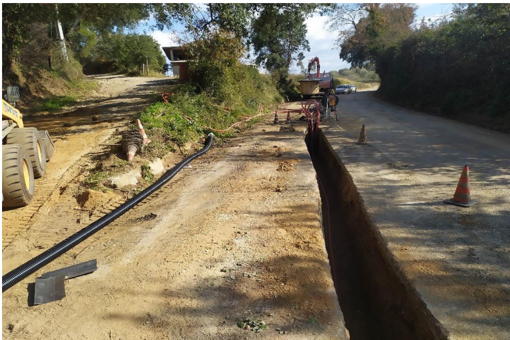
Foto 7 – Posa cavo su SP57
