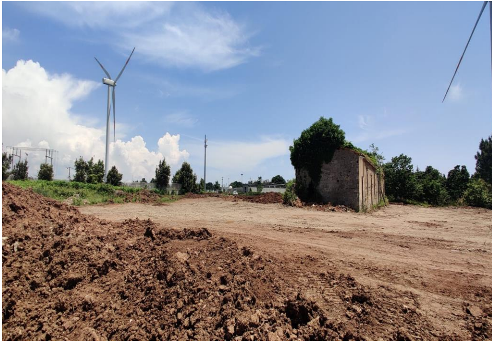
Foto 2 – Sbancamento area componenti elettromeccanici
