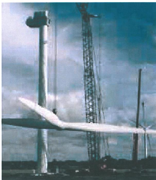
Figura 18: esecuzione del sollevamento delle pale durante la fase di costruzione
