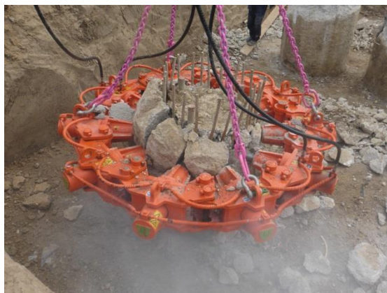
Demolizione con corona idraulica
