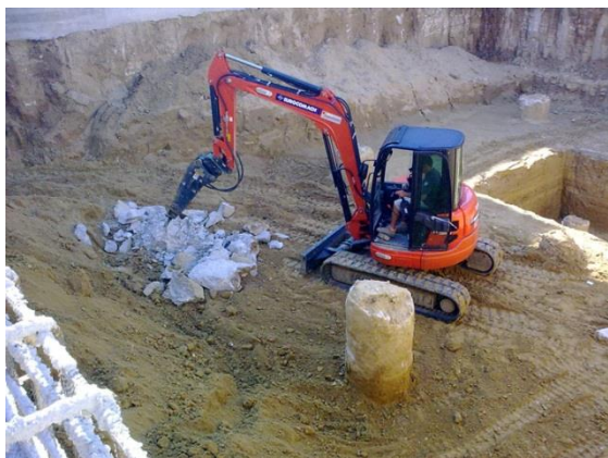
Demolizione con martellone
