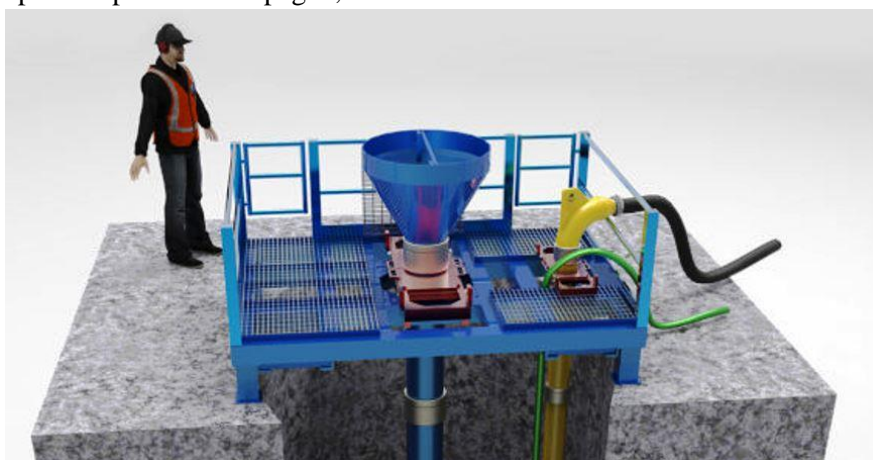
Pedana sostegno tubo getto e protezione pozzo
