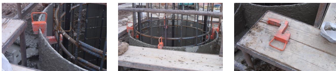
Staffe di sostegno ricavate tramite ossitaglio da lamiere piane di acciaio
