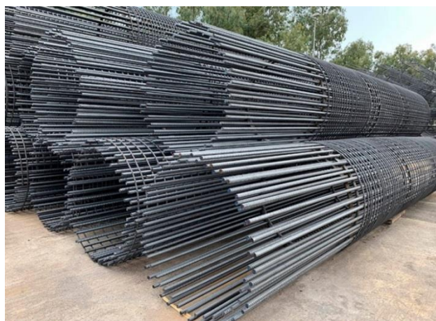
Gabbie di armatura pali
