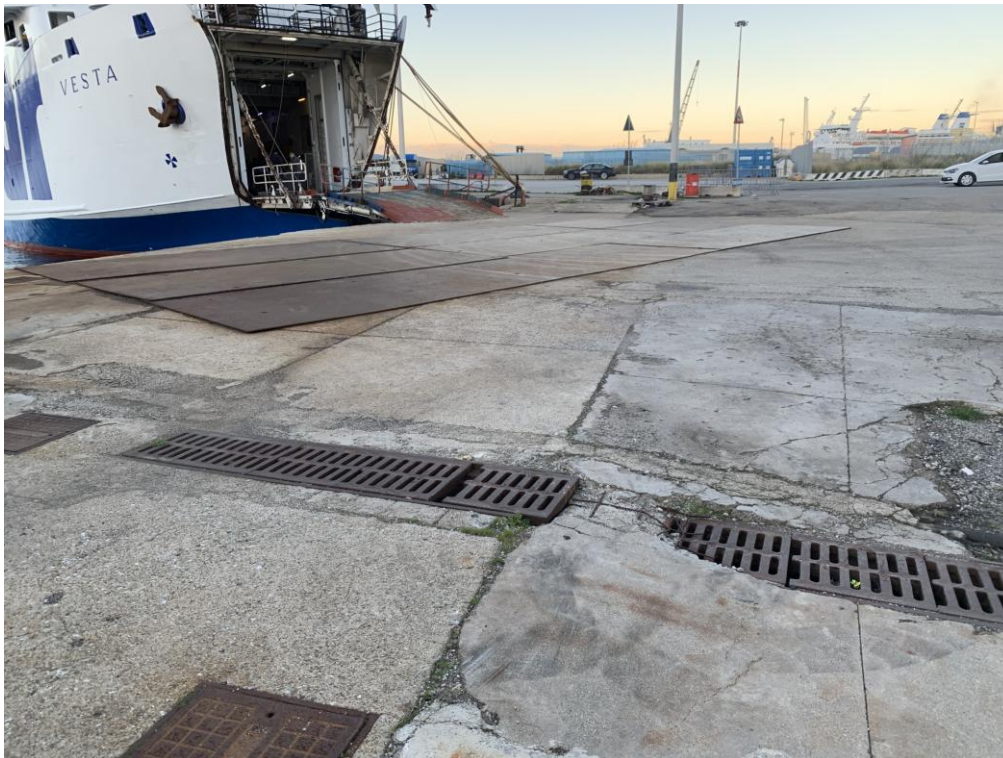
Fig. 7-2 : Canali grigliati esistenti da restaurare
