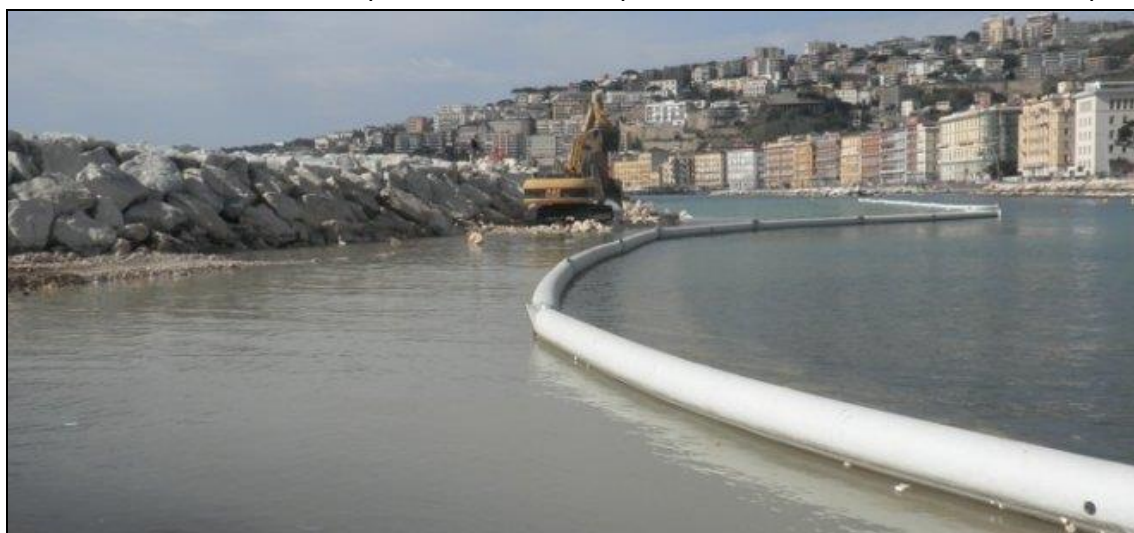
Figura 18: Utilizzo di barriere anti-torbidità durante i lavori
