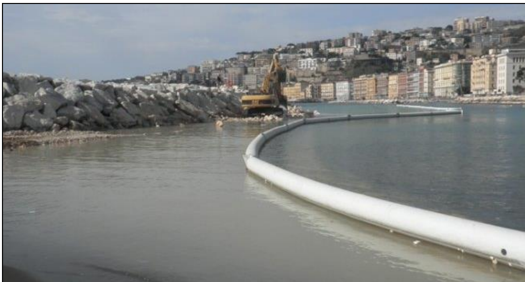
Utilizzo di barriere anti-torbidità durante i lavori
