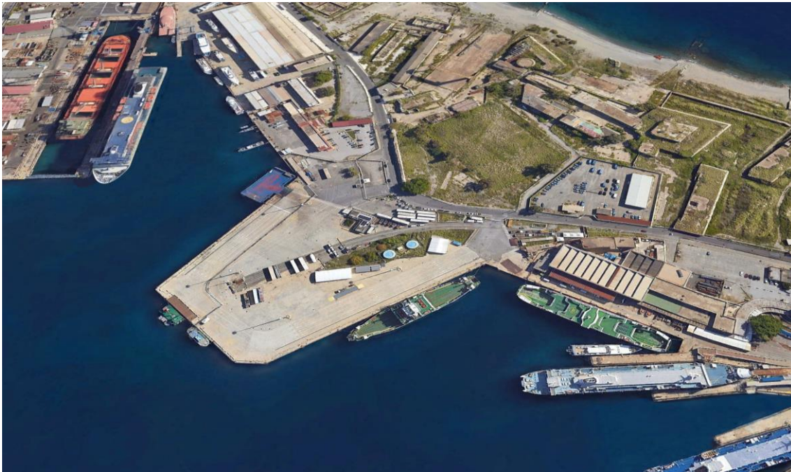
Vista dell'area di intervento ante operam
