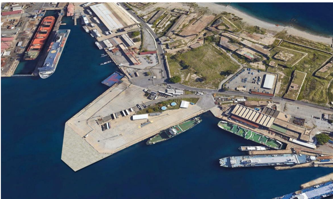
Vista dell'area di intervento post operam
