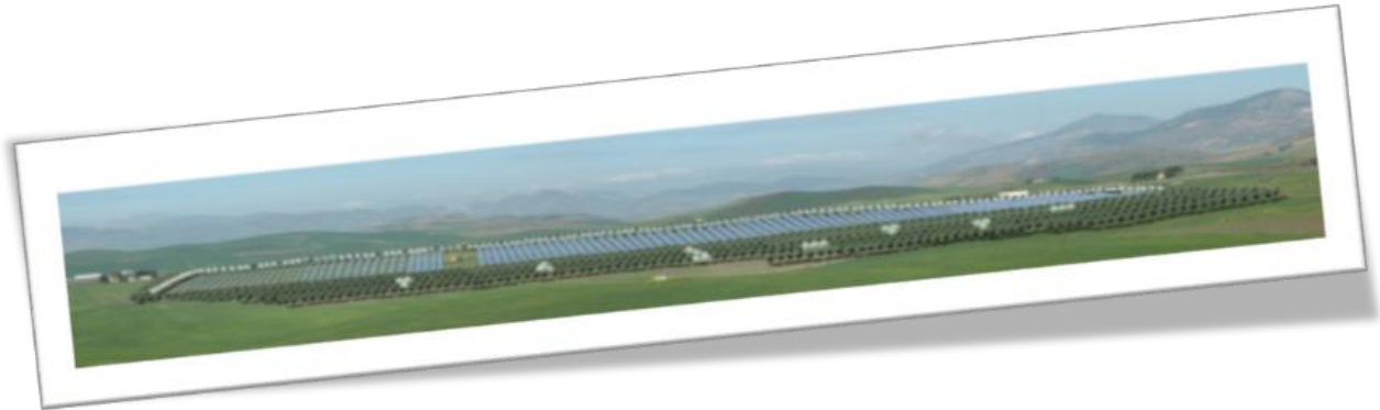
Figura 33 - Impianto fotovoltaico da 5 MW, "Heliospower", Monreale (PA) 2010
