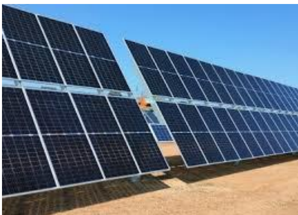
Figura 12: Tracker bifilare
