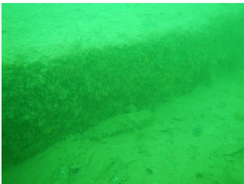
Figura 26. Corpo morto semi sepolto su fondale limaccioso.
