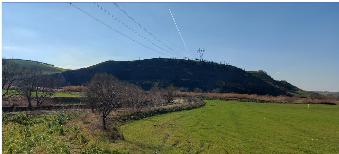
Stato di fatto – Punto di presa fotografica 3
