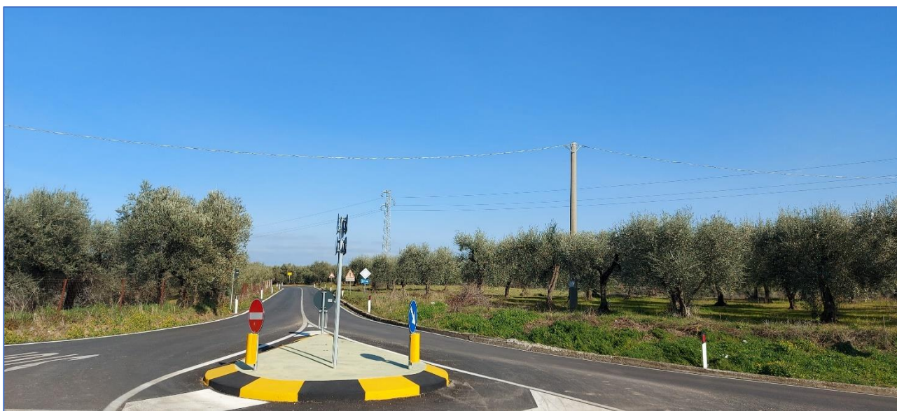
Stato di fatto – Punto di presa fotografica 2a
