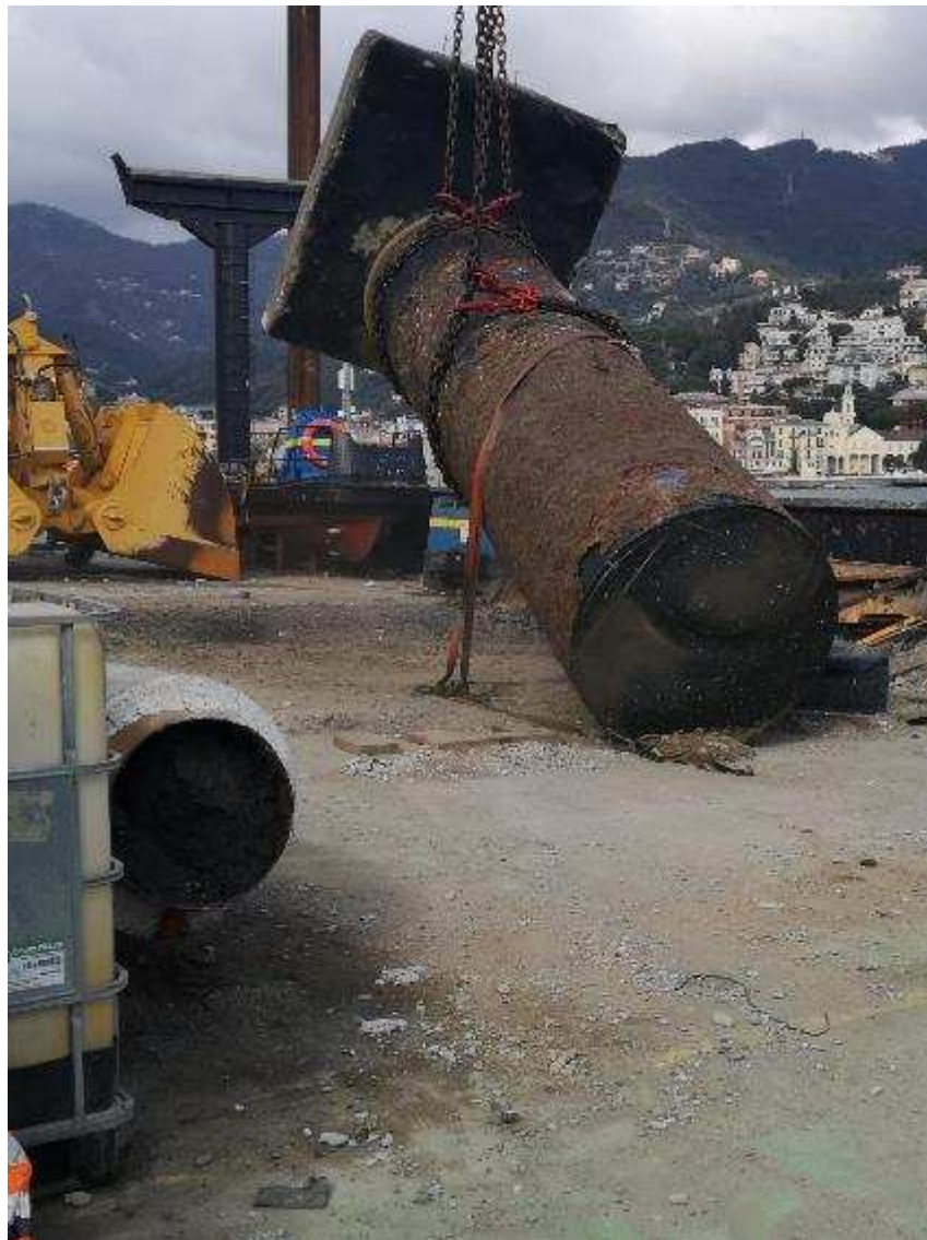
Foto 22: 08.03.2023 – posizionamento in banchina di un palo del pontile N. 1
