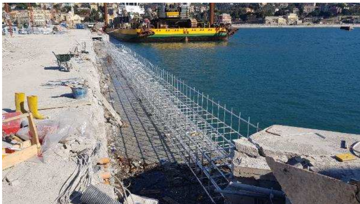
Foto 2: 09.02.2023 – cordolo di banchina Molo Langano
