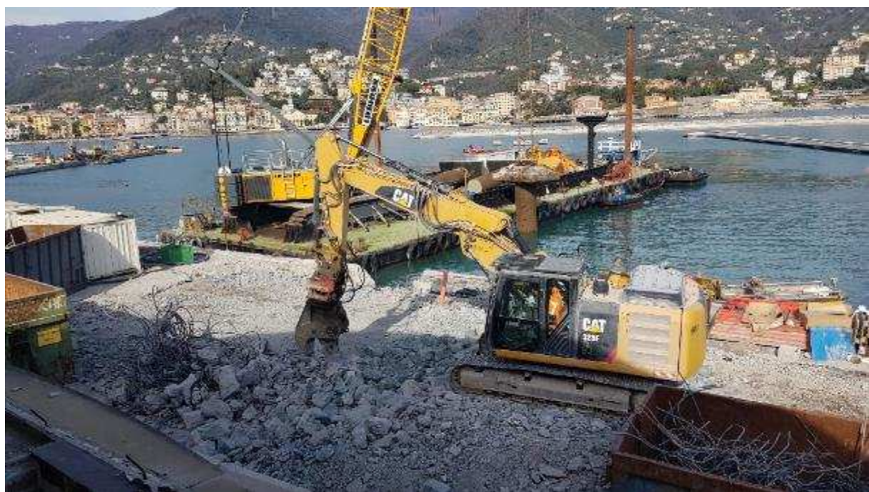
Foto 33: 17.03.2023: demolizione dei pali del pontile n. 1
