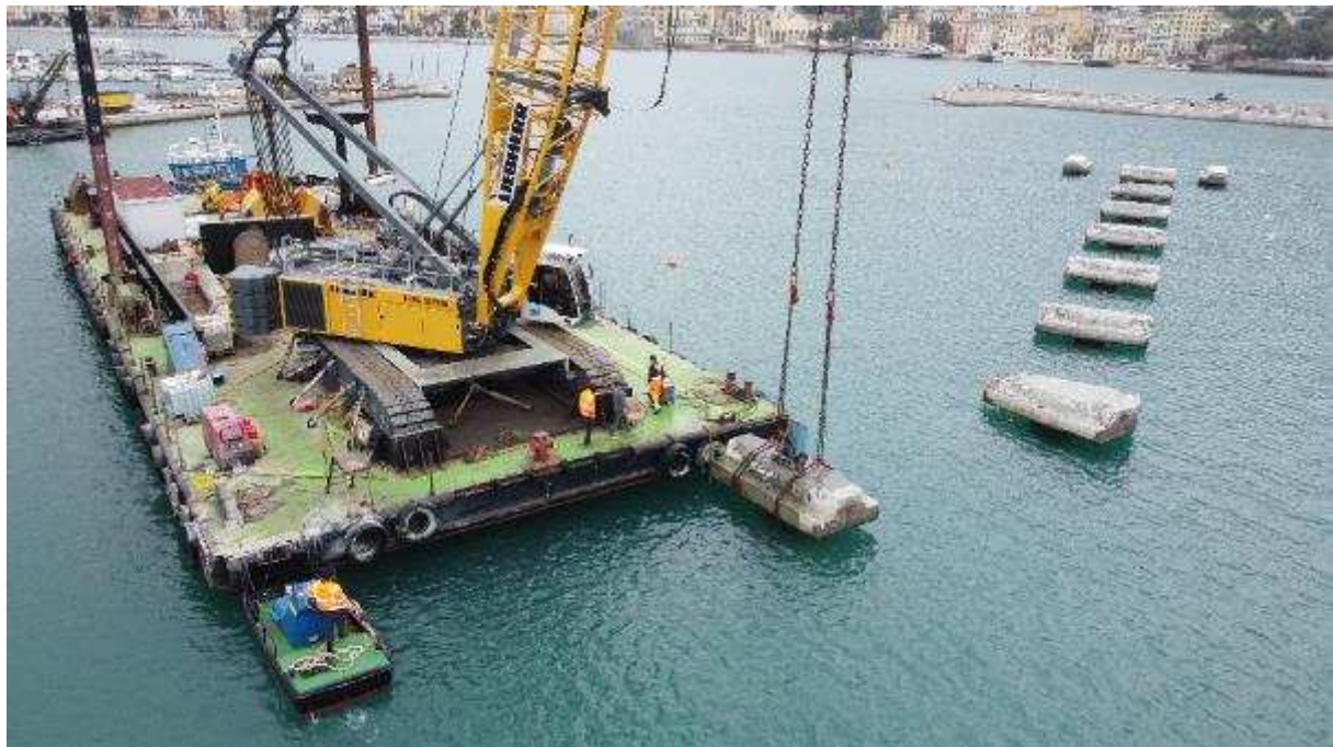
Foto 26: 14.03.2023 – sollevamento di un palo del pontile n. 1
