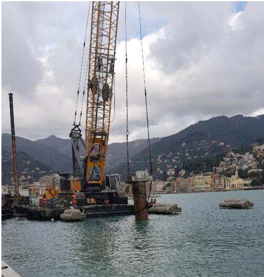
Foto 23: 08.03.2023 – trasporto verso la banchina mediante pontone di un palo del pontile n. 1
