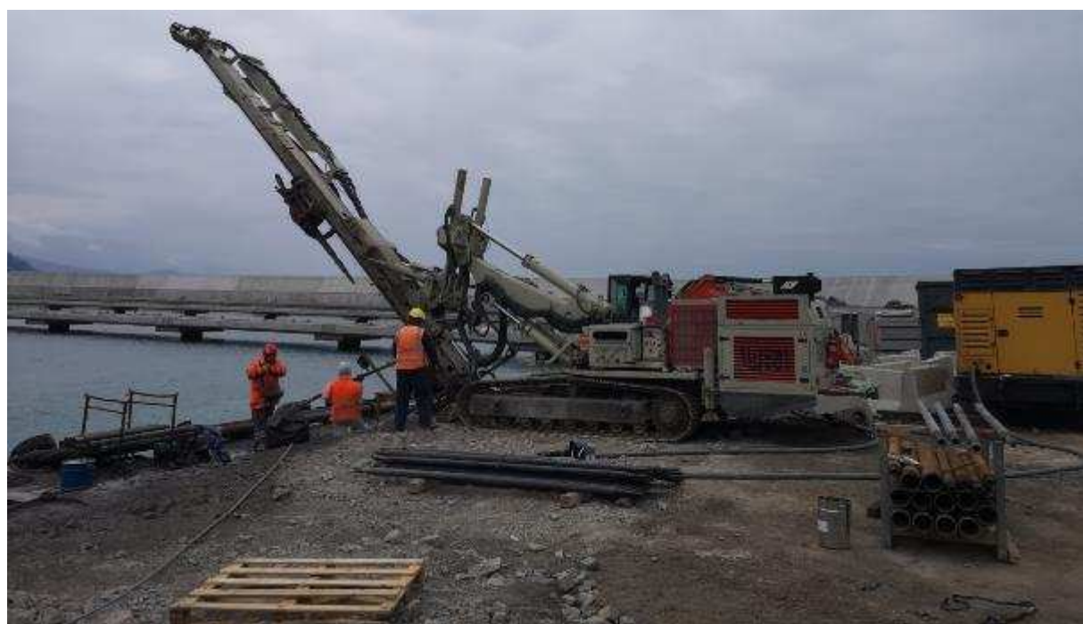
Foto 6: 21.02.2023 – tiranti di consolidamento banchina piazzale
