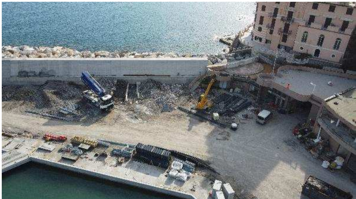
Foto 36: 17.03.2023 – vista delle baie per alloggiamento materiali da demolizione prima dell'avvio a recupero
