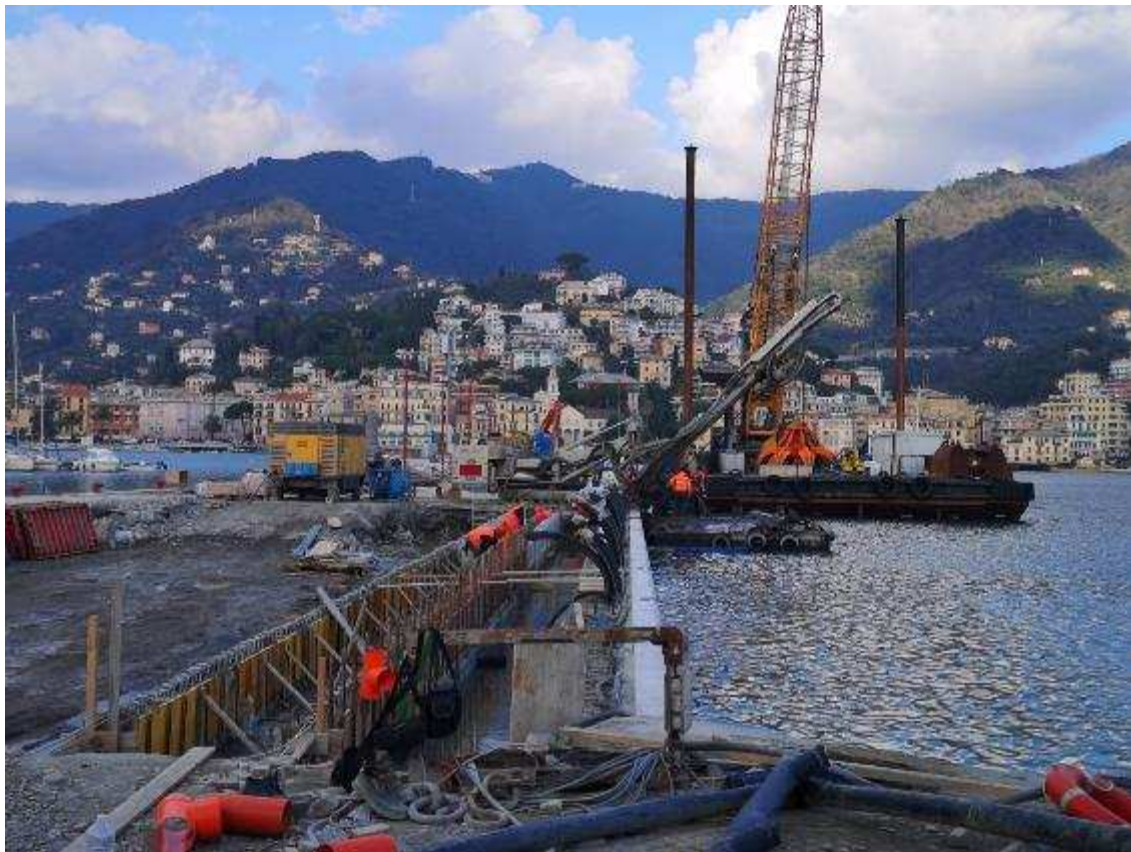
Foto 17: 06.03.2023 – vista di dettaglio del Molo Langano (in corso la costruzione del cordolo di banchina, le perforazioni dei tiranti e il carico dei materiali per gli ormeggi)
