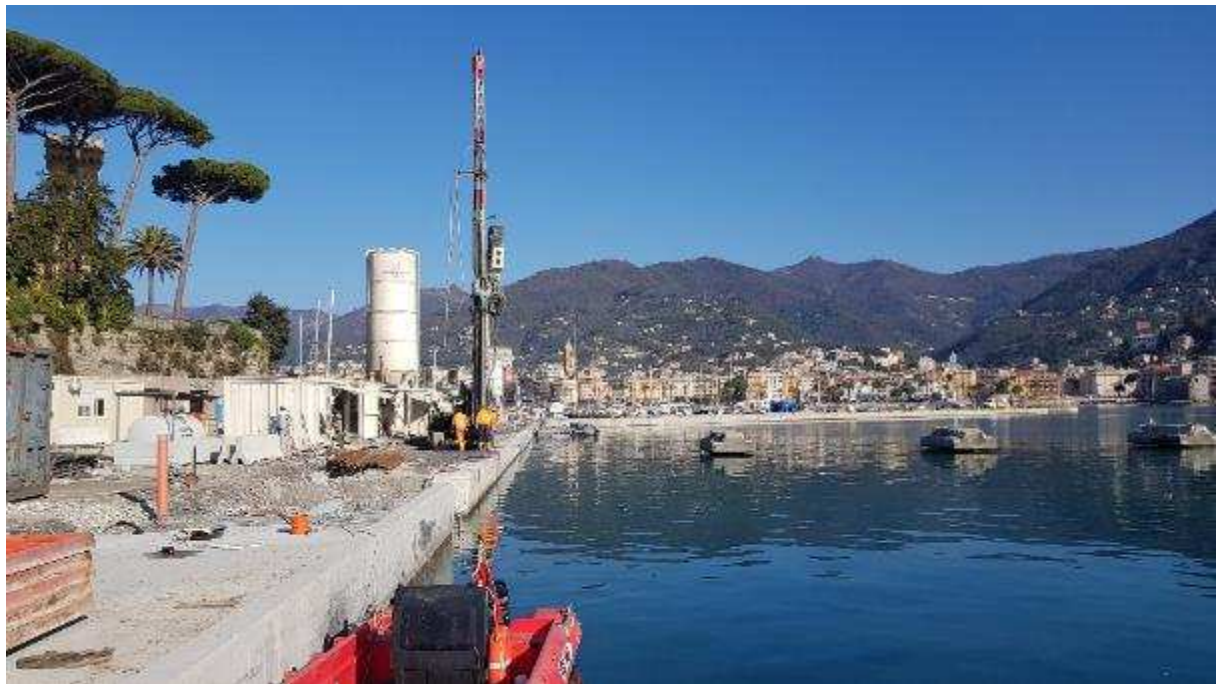
Foto 15: 04.03.2023 - banchina piazzale (in corso il consolidamento con jet-grouting)
