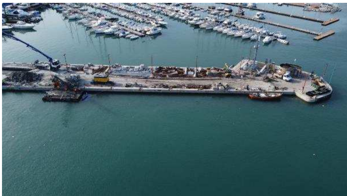
Foto 29: 15.03.2023 – vista del Molo Langano (esecuzione tiranti)
