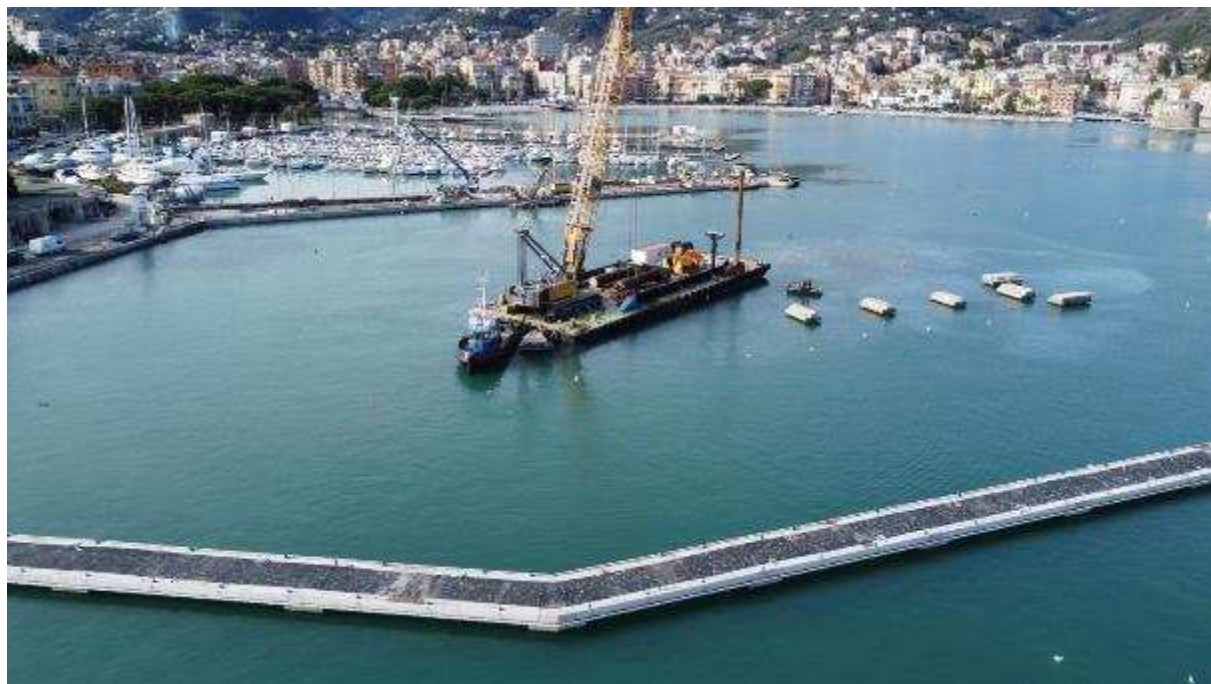
Foto 28: 15.03.2023 – taglio pali pontile n. 1
