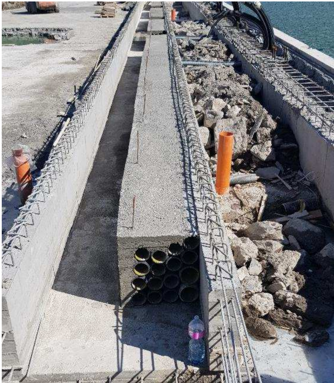
Foto 38: 18.03.2023 – cordolo di banchina del Molo Langano
