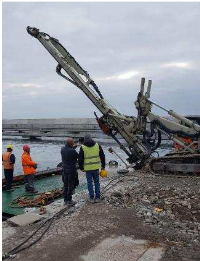
Foto 5: 20.02.2023 – tiranti di consolidamento banchina piazzale
