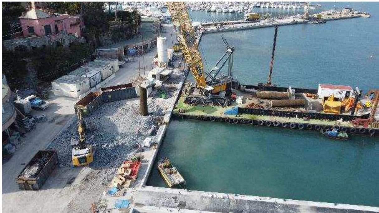
Foto 35: 17.03.2023 – vista della banchina piazzale (area demolizione pali pontile n. 1)
