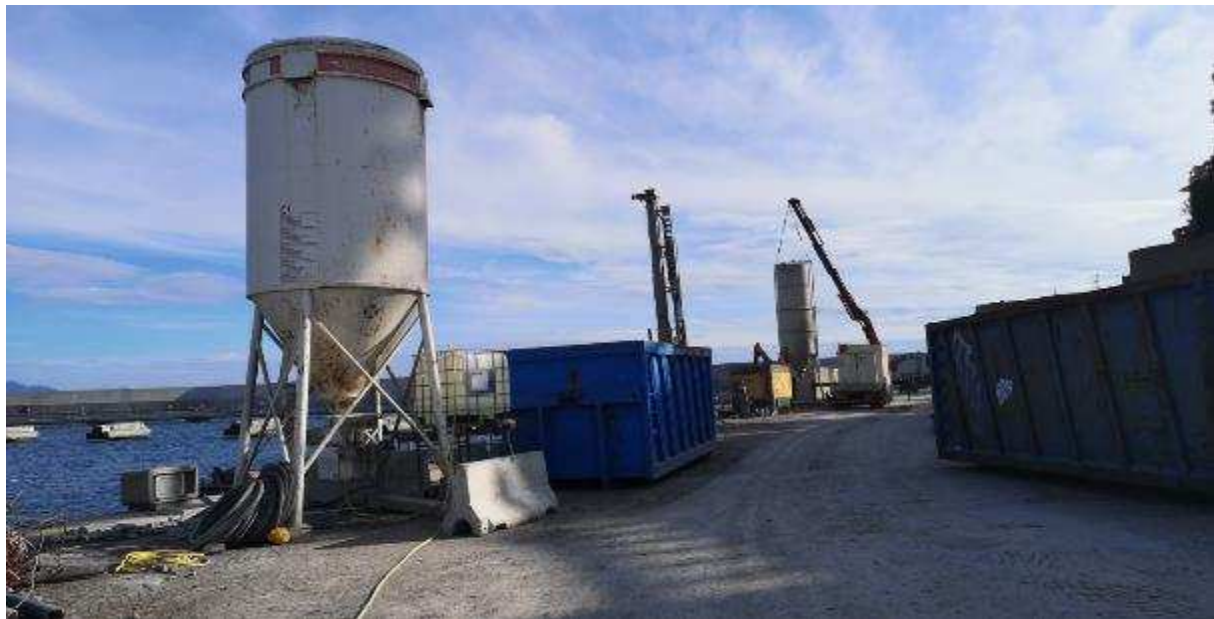
Foto 11: 28.02.2023 – il cantiere per l'esecuzione del consolidamento con jet-grouting
