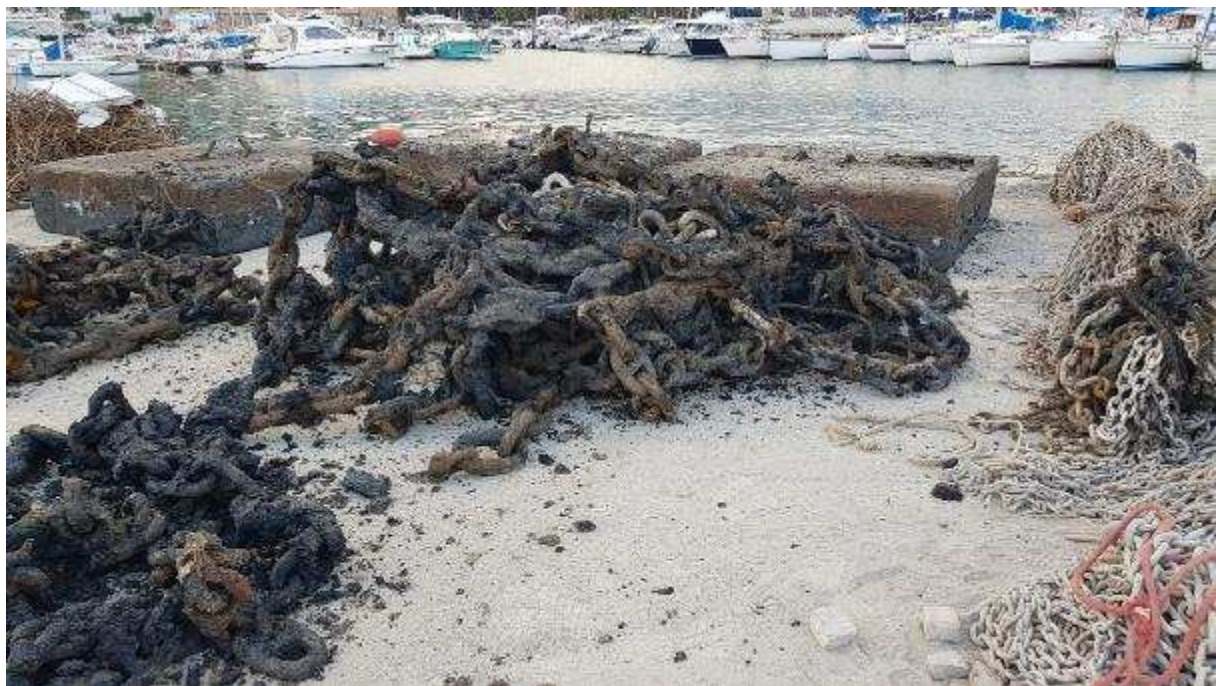
Foto 18: 06.03.2023 - parte delle catene di ormeggio e dei corpi morti recuperati per la manutenzione/sostituzione
