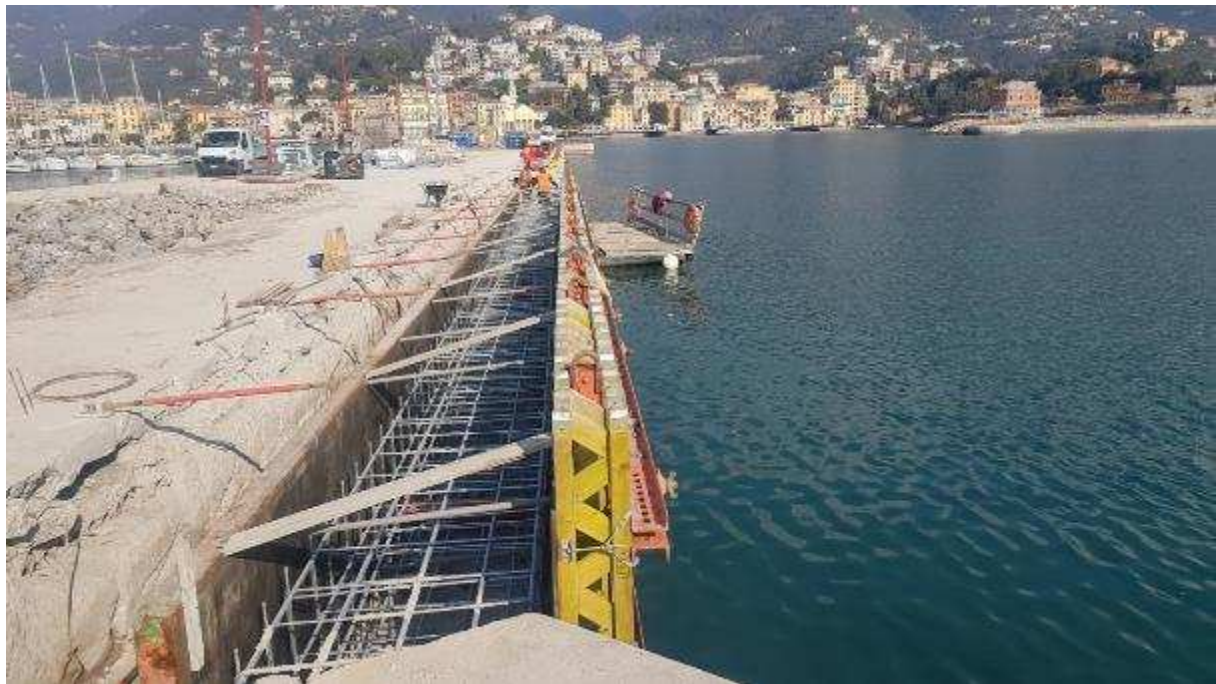
Foto 3: 14.02.2023 – cordolo di banchina Molo Langano
