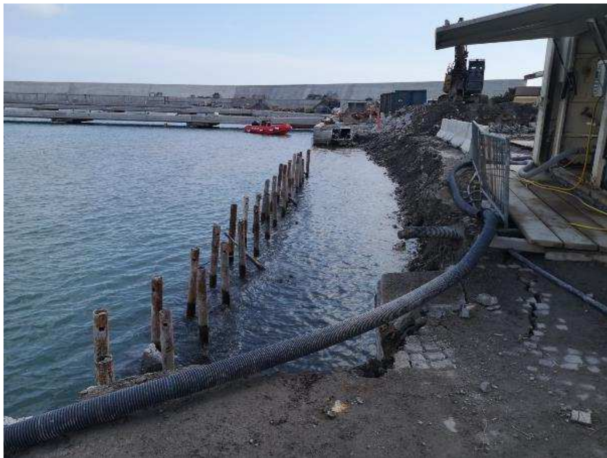
Foto 41: 30.03.2023 – demolizione cordolo banchina piazzale
