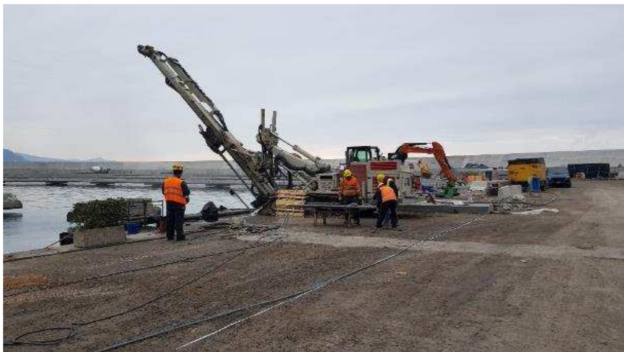
Foto 8: 22.02.2023 – tiranti di consolidamento banchina piazzale
