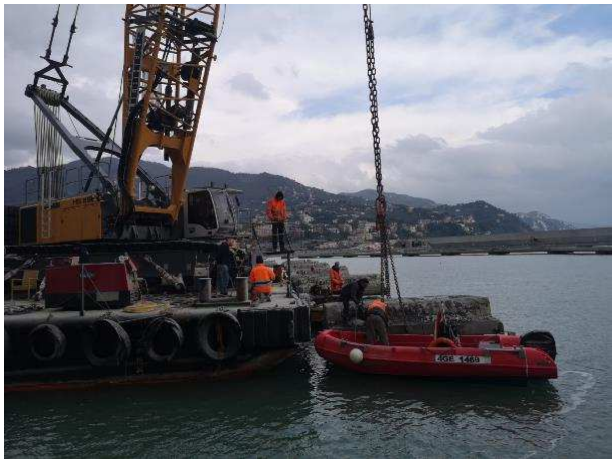
Foto 20: 07.03.2023 – avvio delle operazioni di taglio dei pali del pontile N. 1
