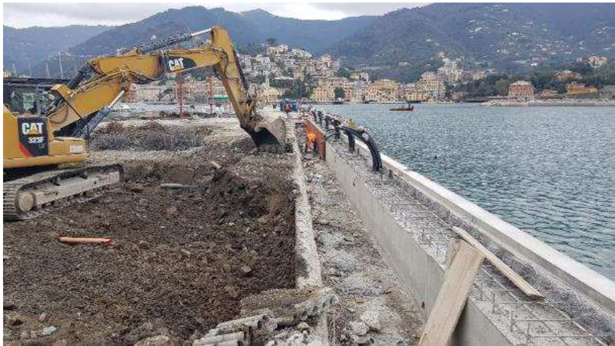
Foto 7: 21.02.2023 – cordolo di banchina Molo Langanò
