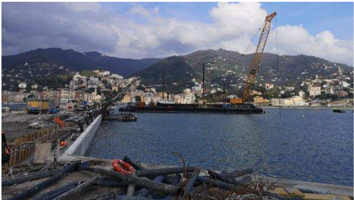
Foto 16: 06.03.2023 – vista del Molo Langano (in corso la costruzione del cordolo di banchina, le perforazioni dei tiranti e il carico dei materiali per gli ormeggi)
