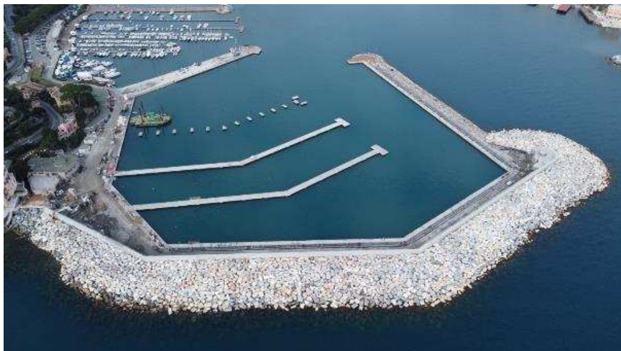
Foto 1: 03.02.2023 – condizioni dell'area all'inizio dei lavori
