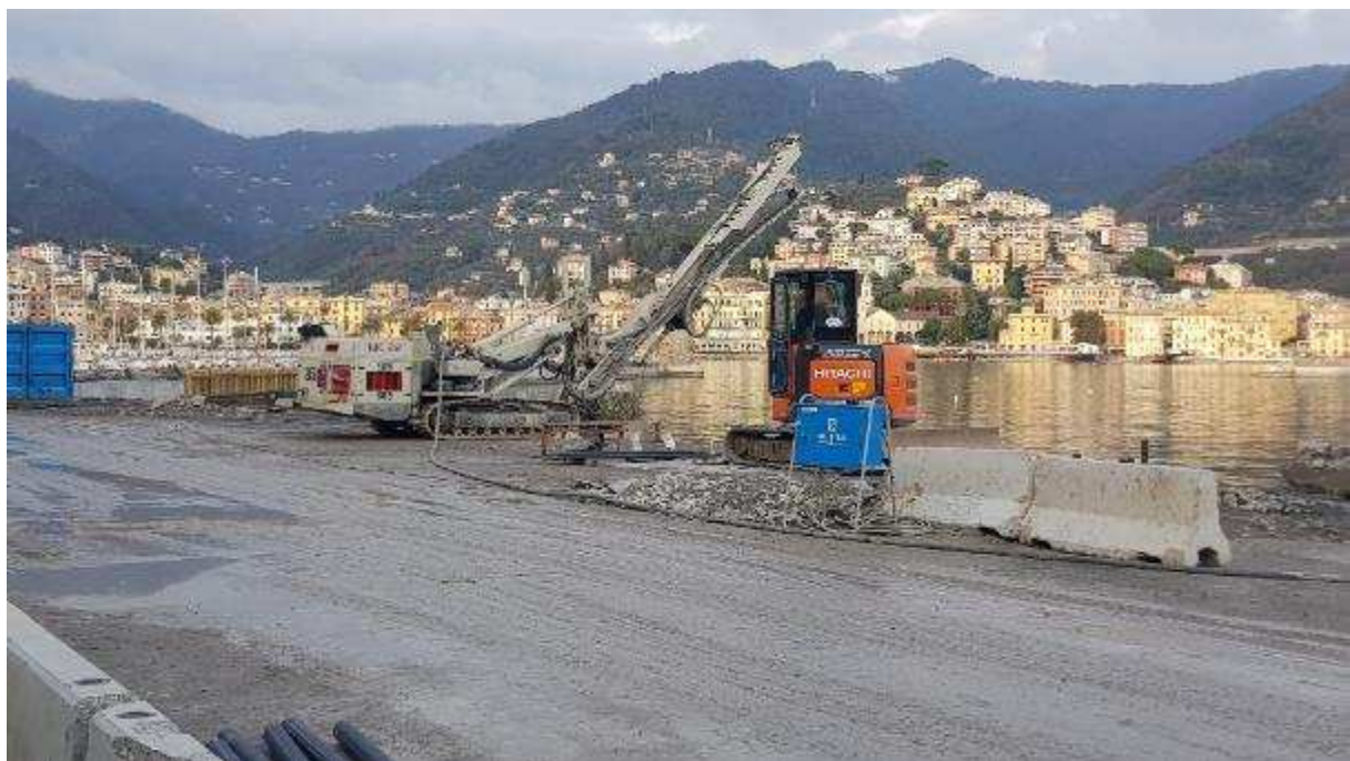
Foto 10: 23.02.2023 – tiranti di consolidamento banchina piazzale
