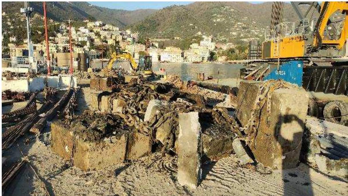
Foto 24: 11.03.2023 - parte delle catene di ormeggio e dei corpi morti recuperati per la manutenzione/sostituzione
