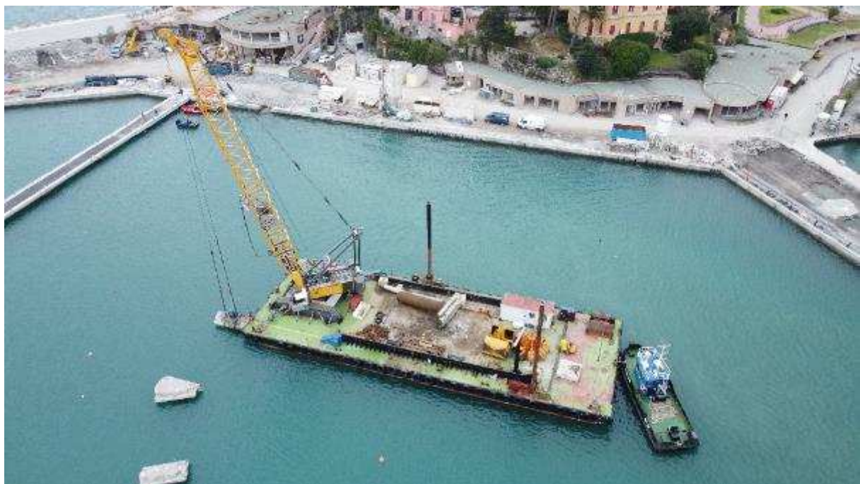
Foto 25: 14.03.2023 – sollevamento di un palo del pontile n. 1
