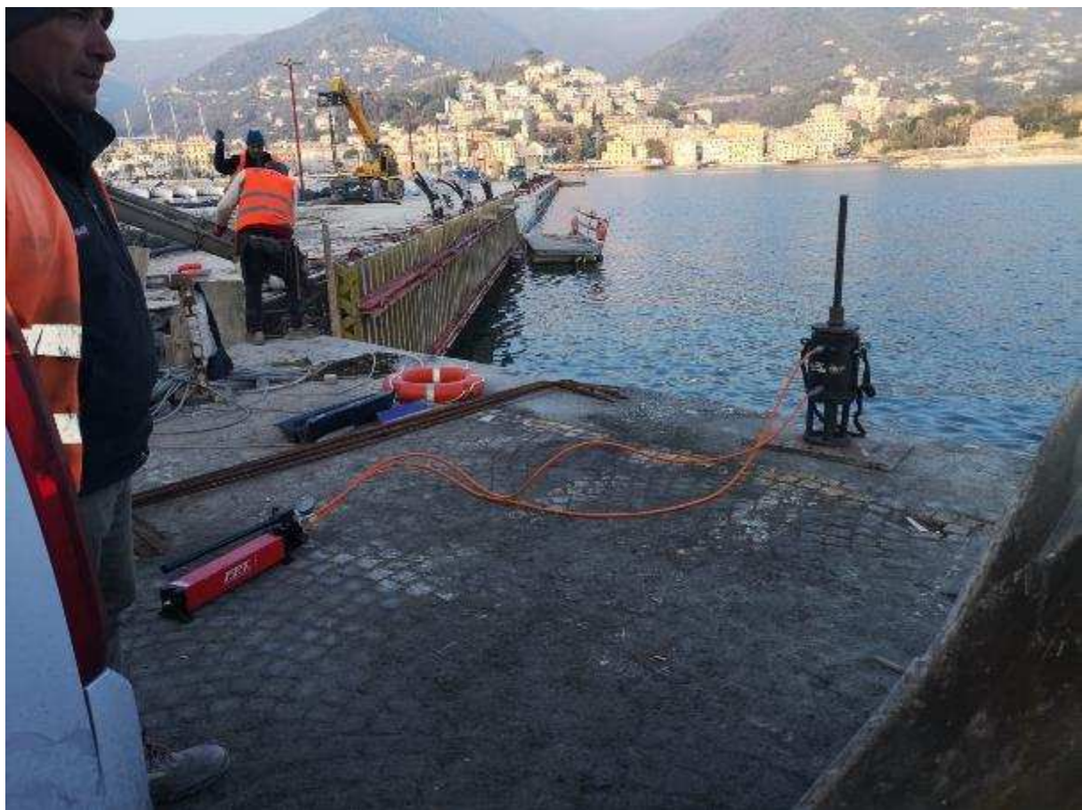
Foto 4: 15.02.2023 - cordolo di banchina Molo Langano e test per le perforazioni
