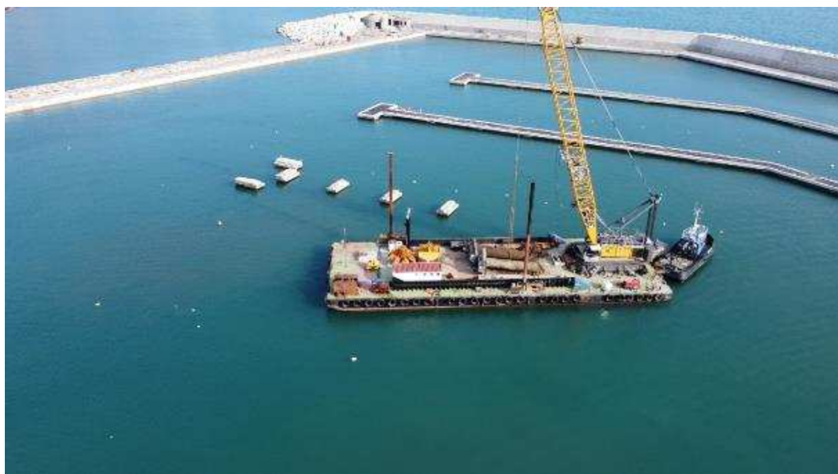
Foto 31: 15.03.2023 – taglio pali pontile n. 1
