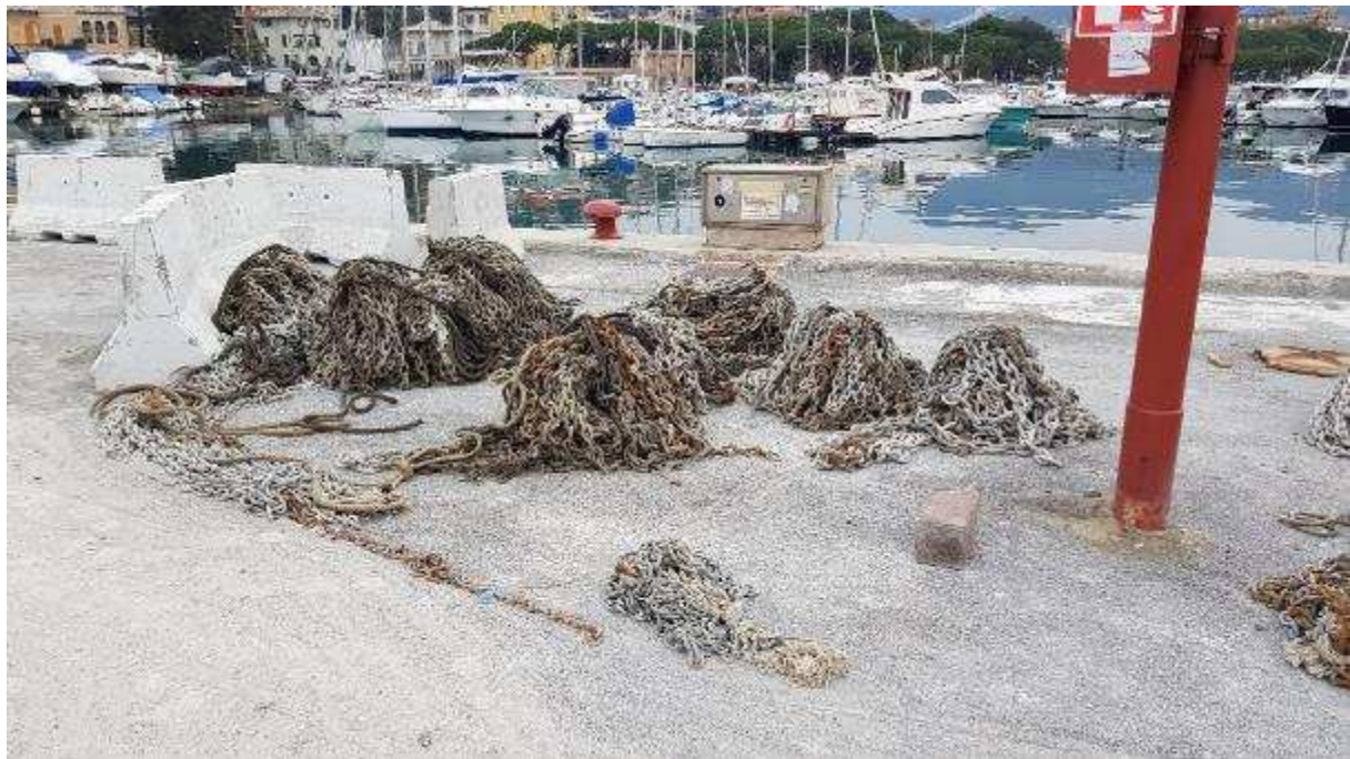
Foto 9: 22.02.2023 – parte delle catene di ormeggio recuperate per la manutenzione/sostituzione
