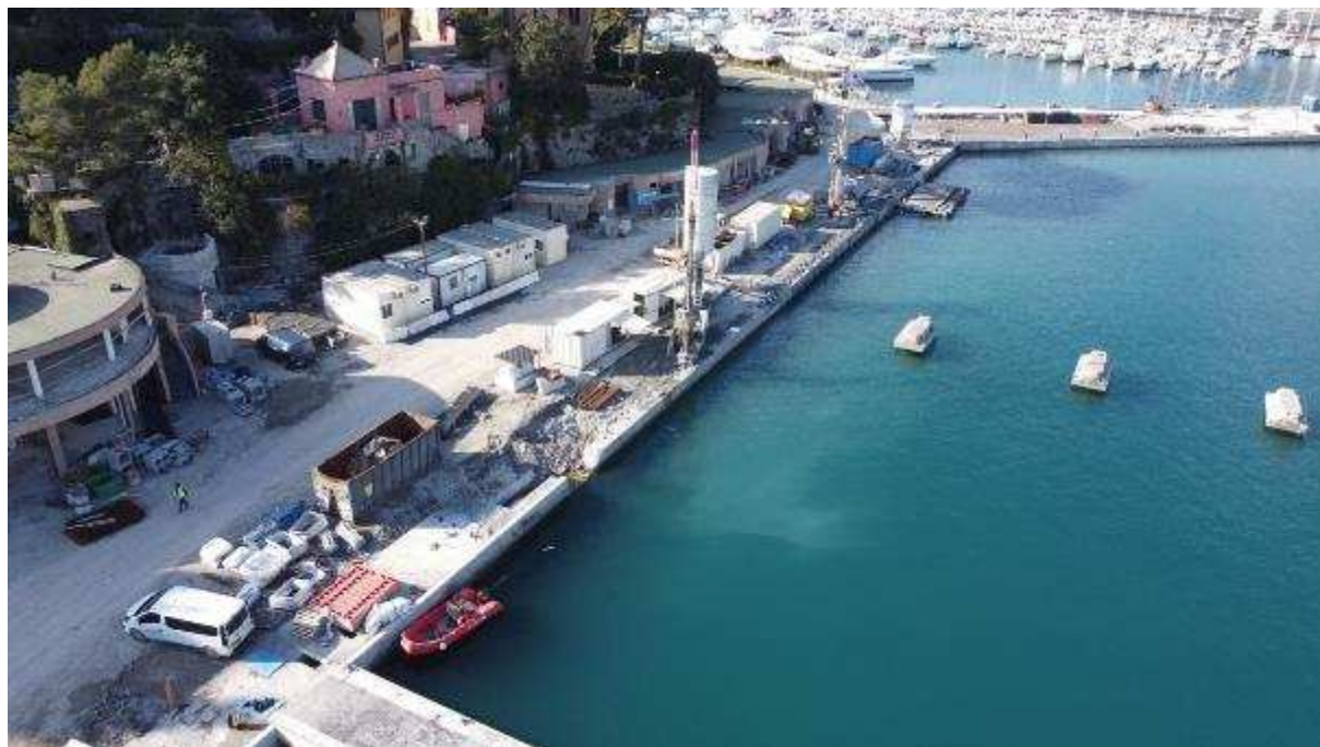
Foto 13: 03.03.2023 – vista da drone della banchina piazzale (in corso l'esecuzione dei tiranti e il consolidamento con jet-grouting)
