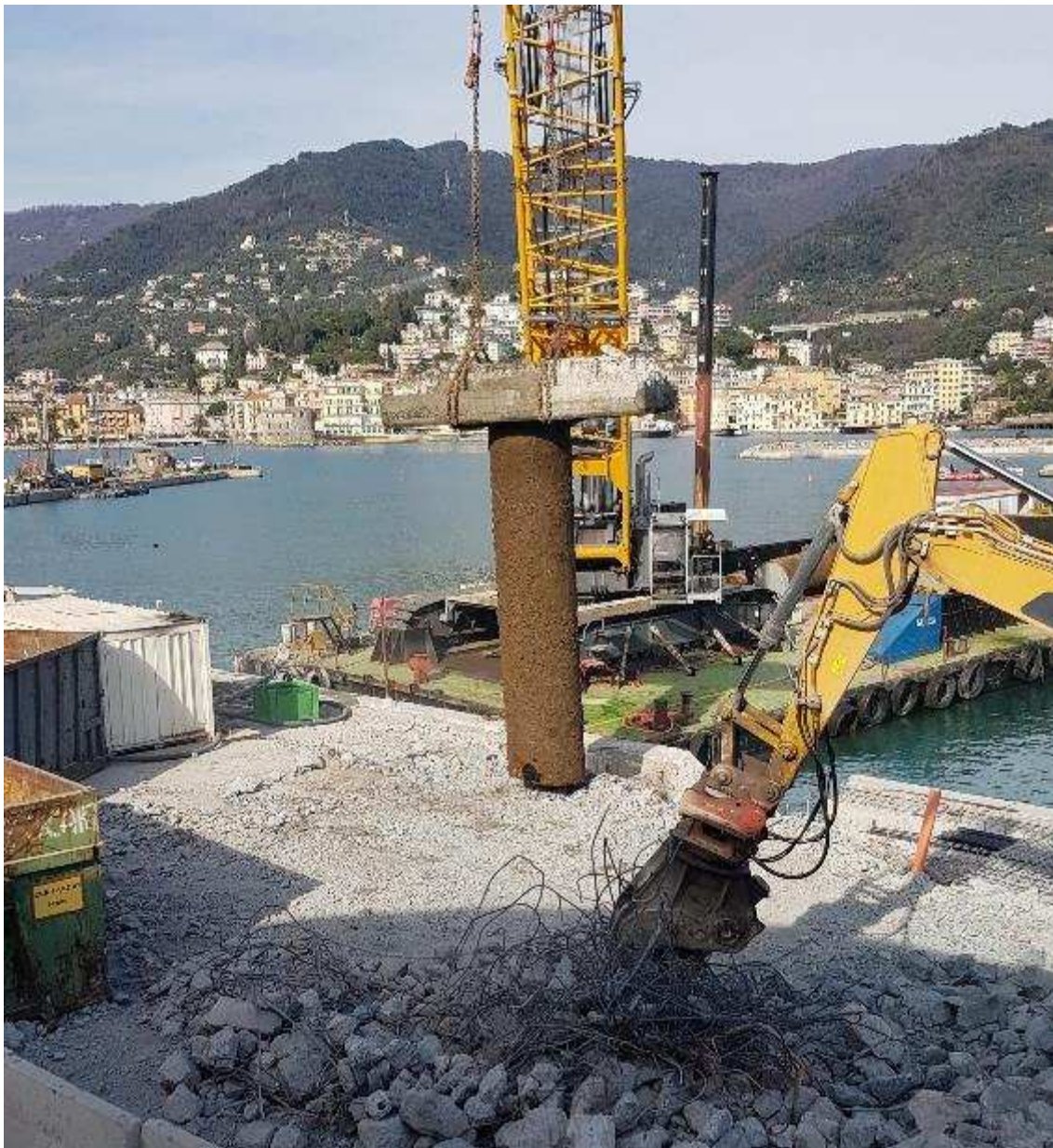
Foto 34: 17.03.2023 – trasporto pali da pontile n. 1 e demolizione degli stessi
