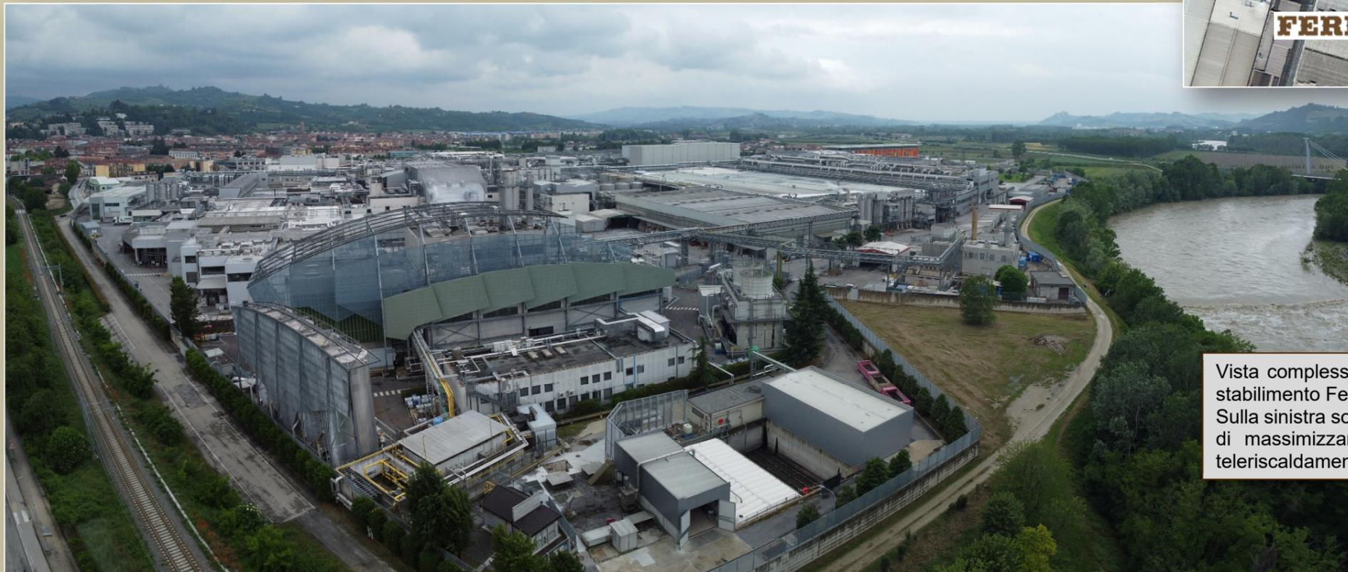
Vista complessiva della Centrale di cogenerazione, dietro la quale si estende lo stabilimento Ferrero e sullo sfondo la Città di Alba. Sulla sinistra sono visibili i 5 serbatoi di accumulo dell'acqua calda che consentono di massimizzare la produzione in cogenerazione del calore per la rete di teleriscaldamento della Città di Alba.
