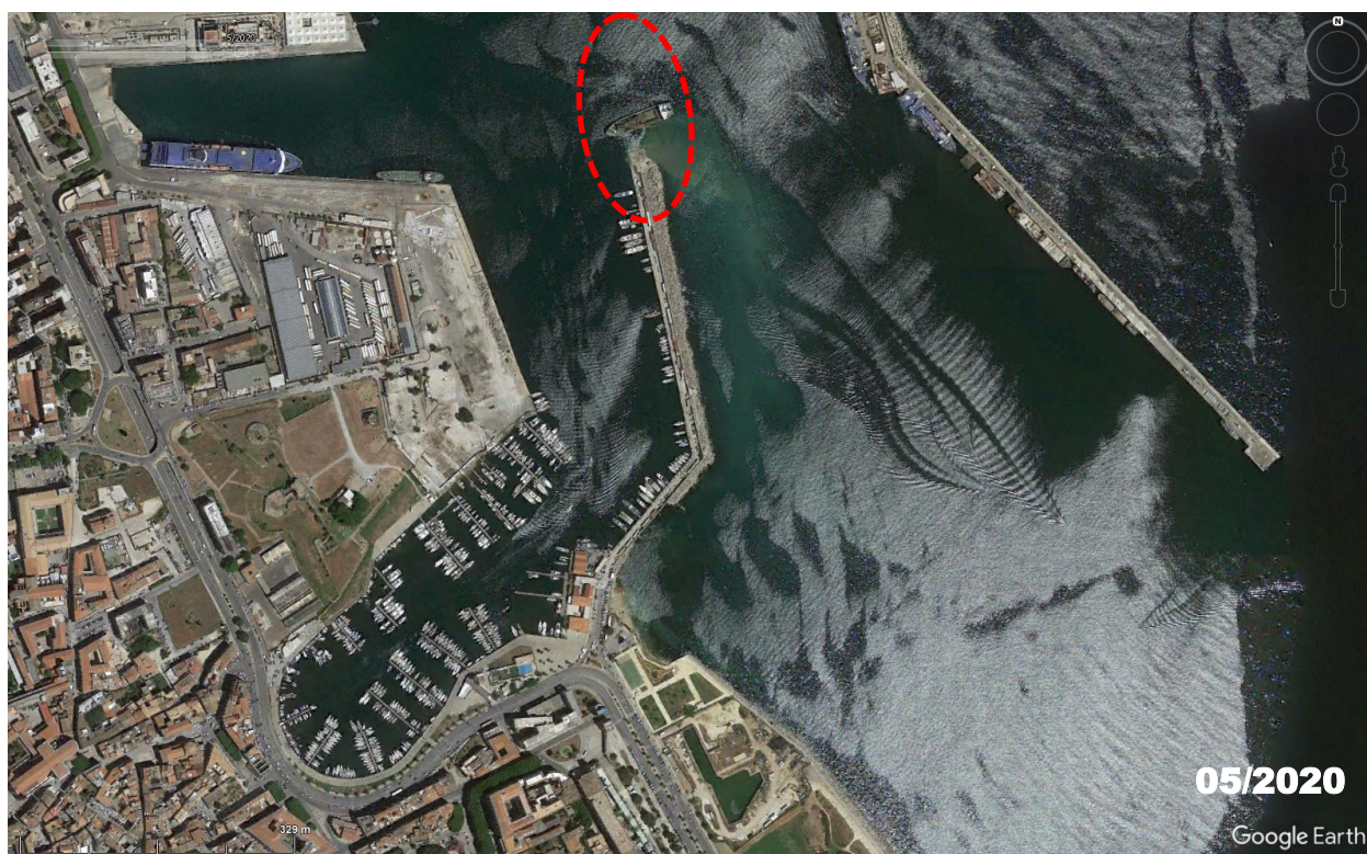
Figura 2-9: Inizio riconfigurazione Molo Sud, lavori in Corso di salpamento della testata
