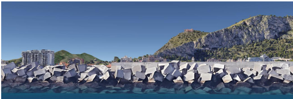
Figura 7-7: Mantellata attuale in massi di cls parallelepipedi posti alla rinfusa a più strati
