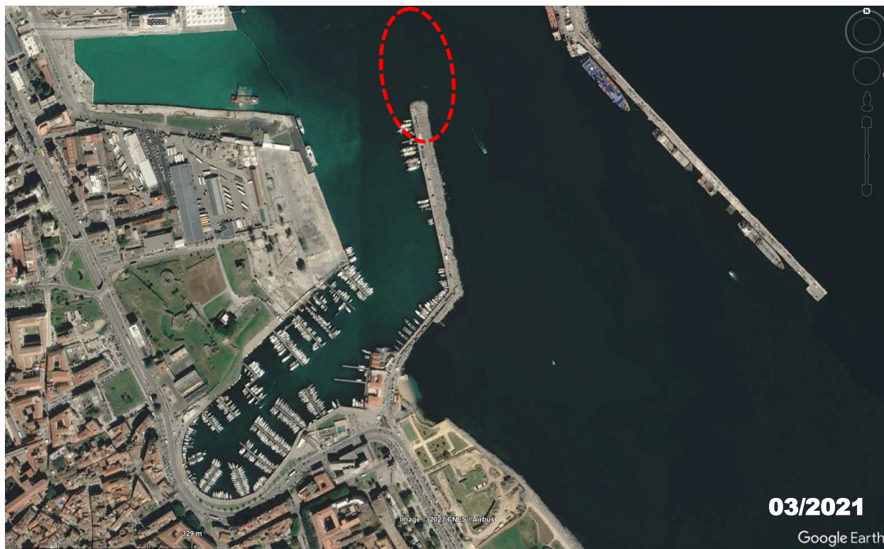
Figura 2-10: Inizio riconfigurazione Molo Sud, salpamento della testata a lavori ultimati
