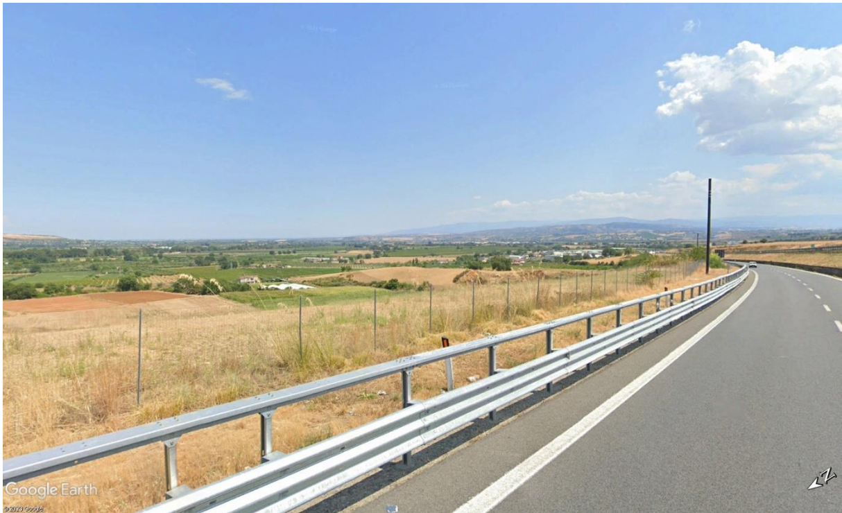
Figura 16-76 - Punto di vista panoramico PV05 su autostrada E45 – zona Masseria Laghi, Comune di Saracena (CS)
