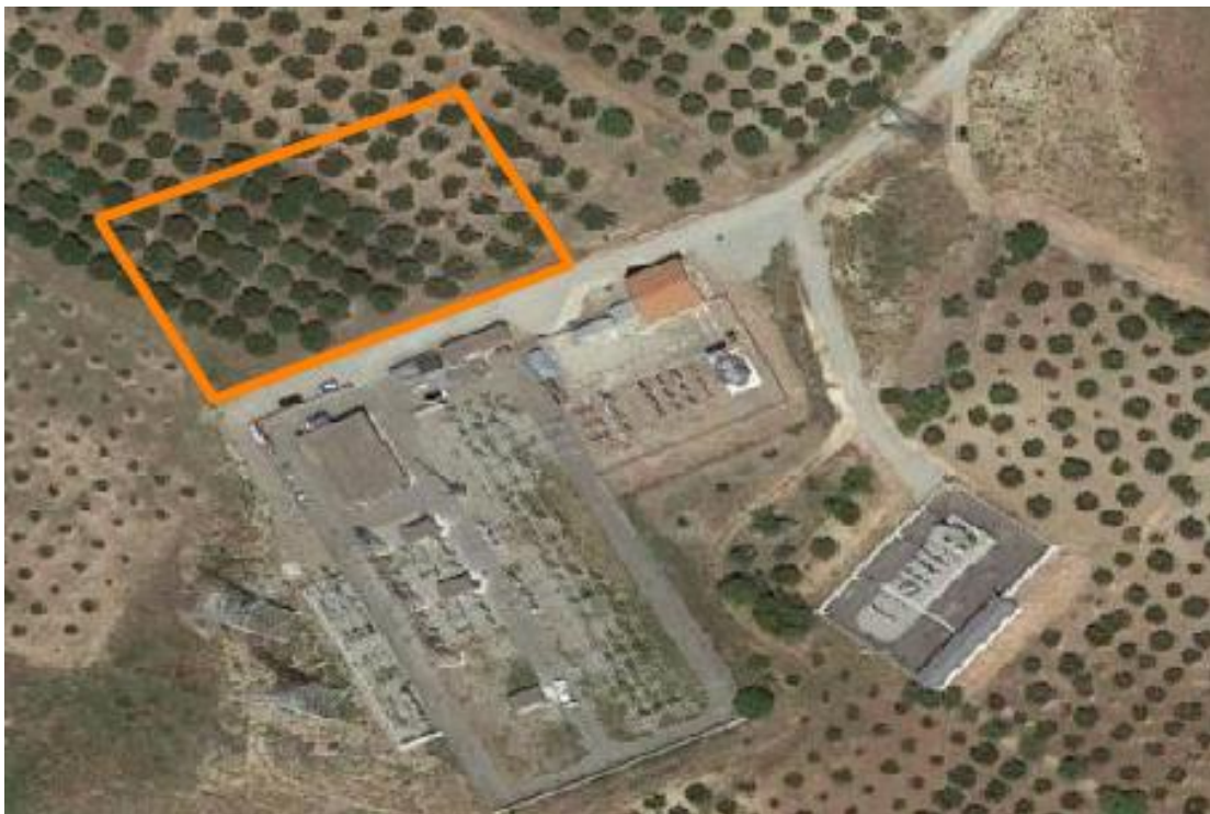
Figura 17-16 Ubicazione della nuova Stazione Elettrica di Trasformazione (in arancione) su immagini satellitari
