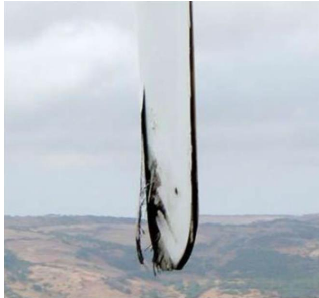
Figura 17-26 Estremità della pala danneggiata da fulminazione atmosferica
