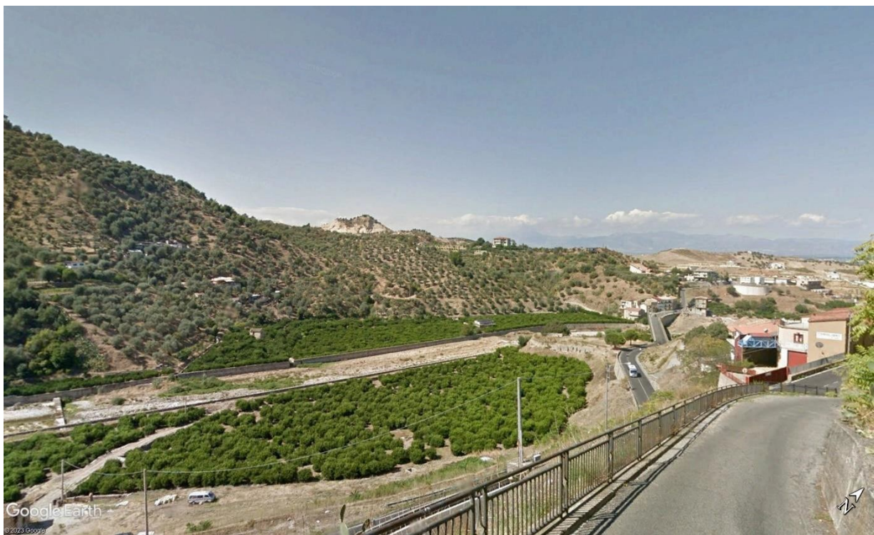
Figura 16-81 - Punto di vista panoramico PV10 su Corigliano Calabro – Vico III Isonzo, Centro storico di Corigliano Calabro (CS)
