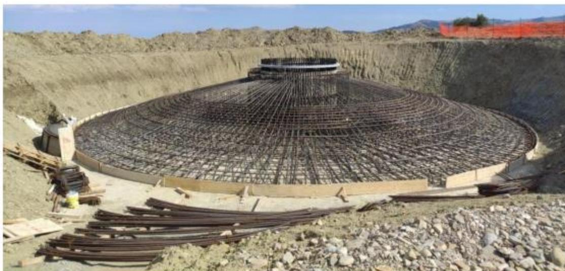
*Figura 9 - Armatura plinto tipo*
