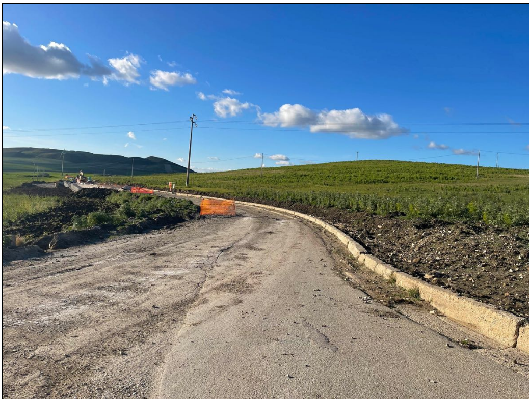
Foto 28 - Panoramica UR 10 (cavidotto interrato)
