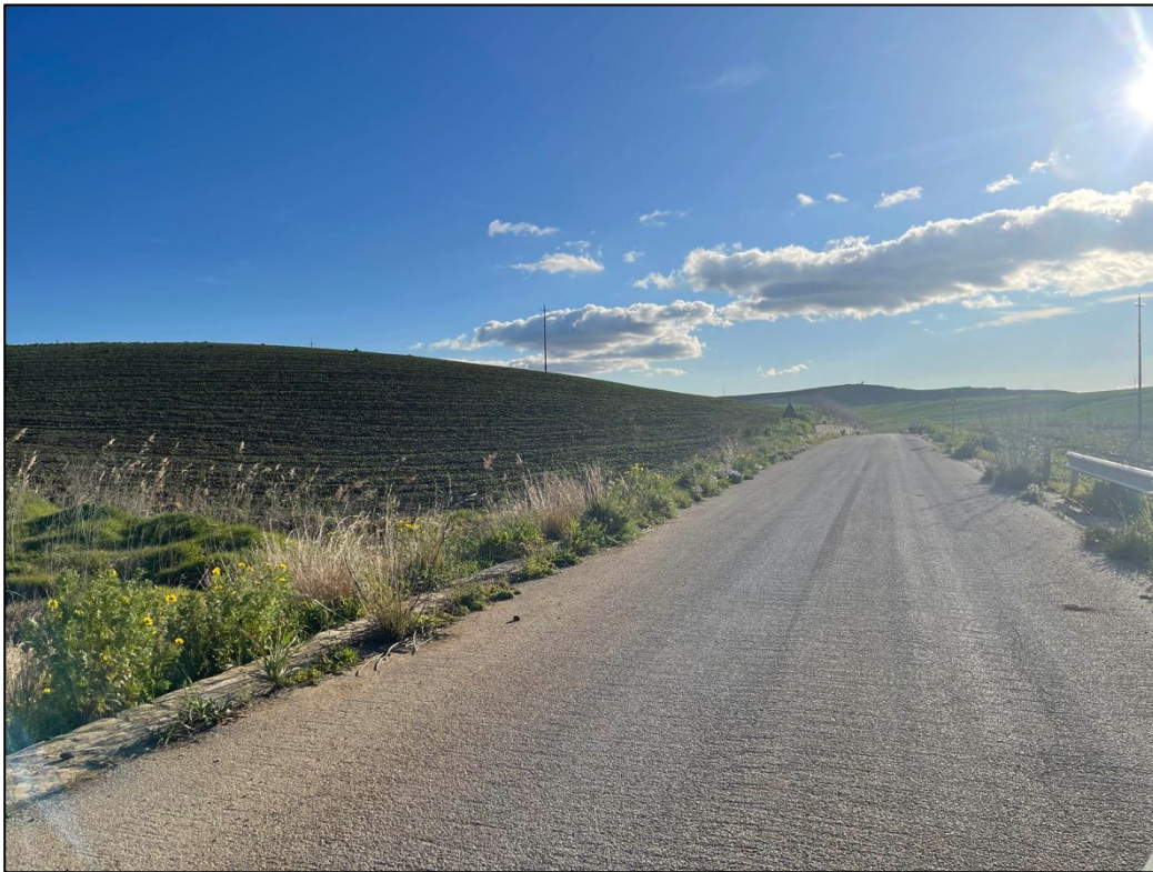
Foto 27 - Panoramica UR 10 (cavidotto interrato)
