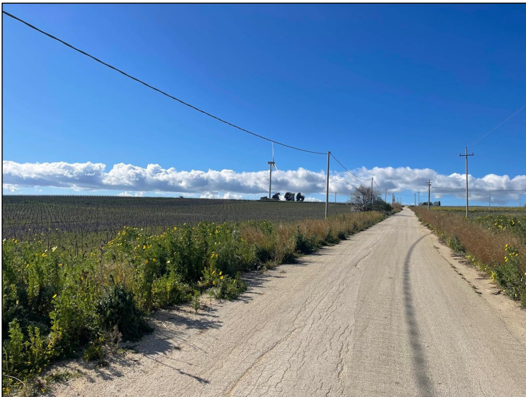
Foto 4 - Panoramica UR 02 (cavidotto interrato)
