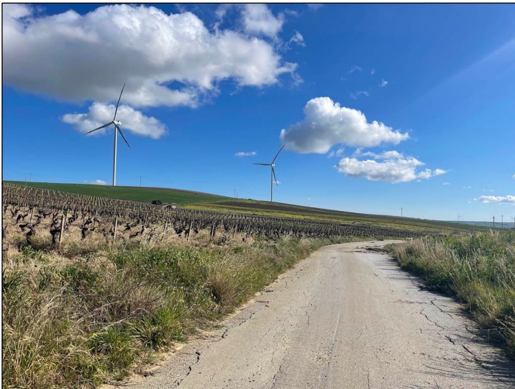
Foto 12 - Panoramica UR 05 (cavidotto interrato)
