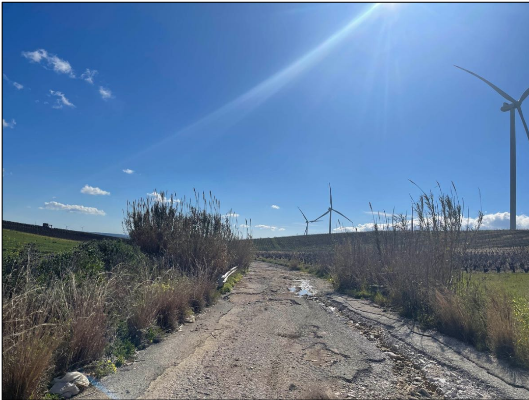
Foto 11 - Panoramica UR 05 (cavidotto interrato)
