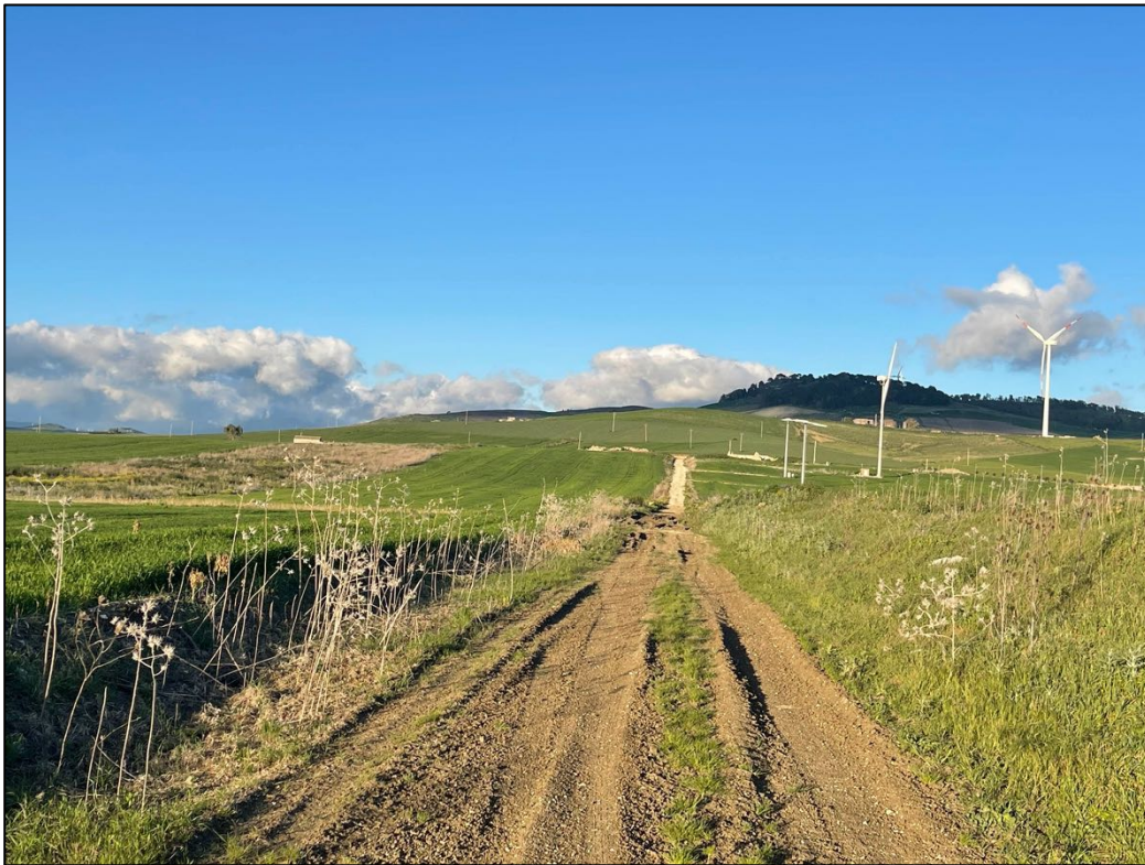
Foto 29 - Panoramica UR 11 (cavidotto interrato)
