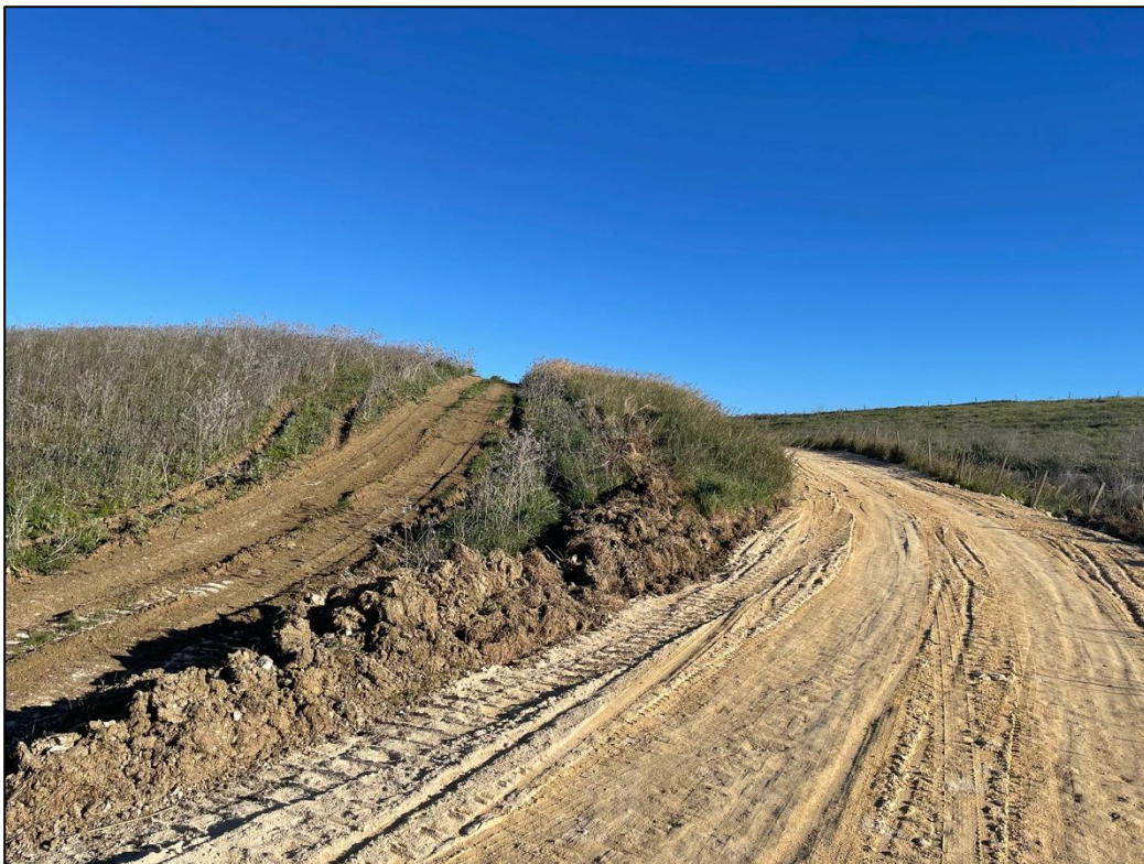
Foto 26 - Panoramica UR 09 (cavidotto interrato)
