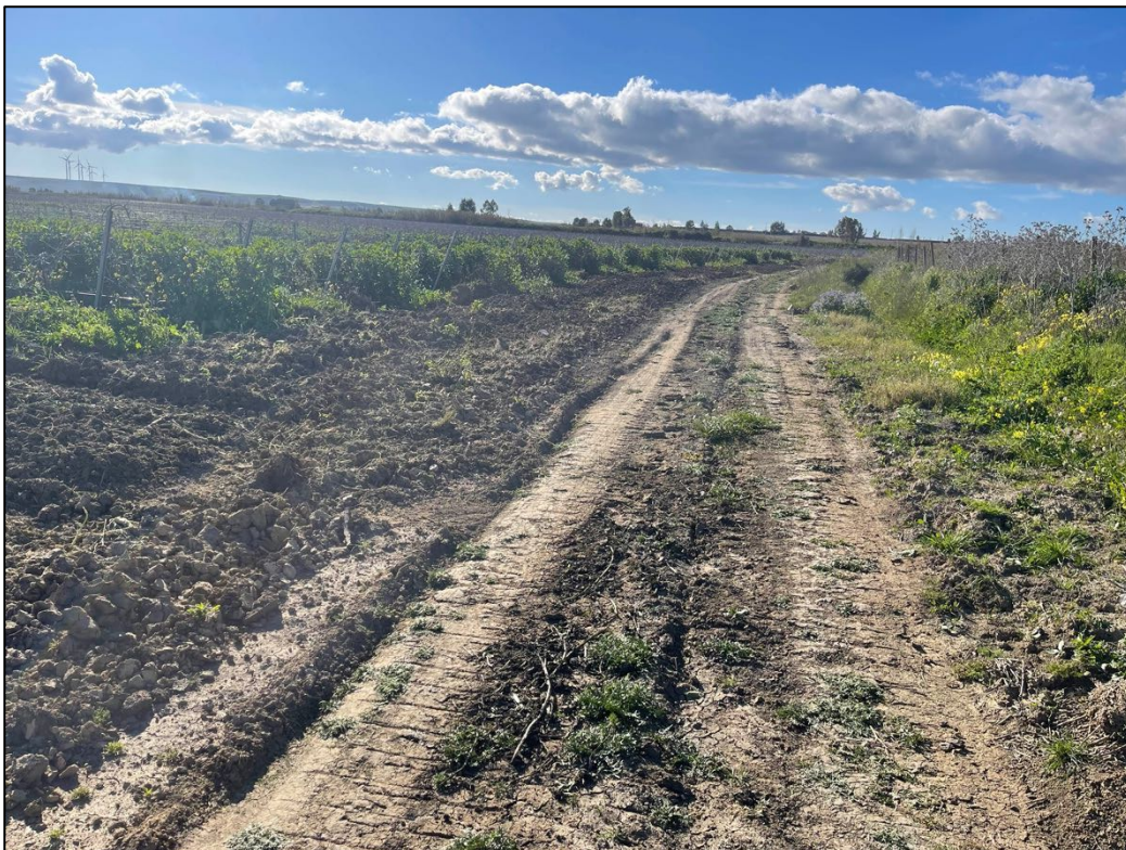
Foto 16 - Panoramica UR 06 (aerogeneratore A01)
