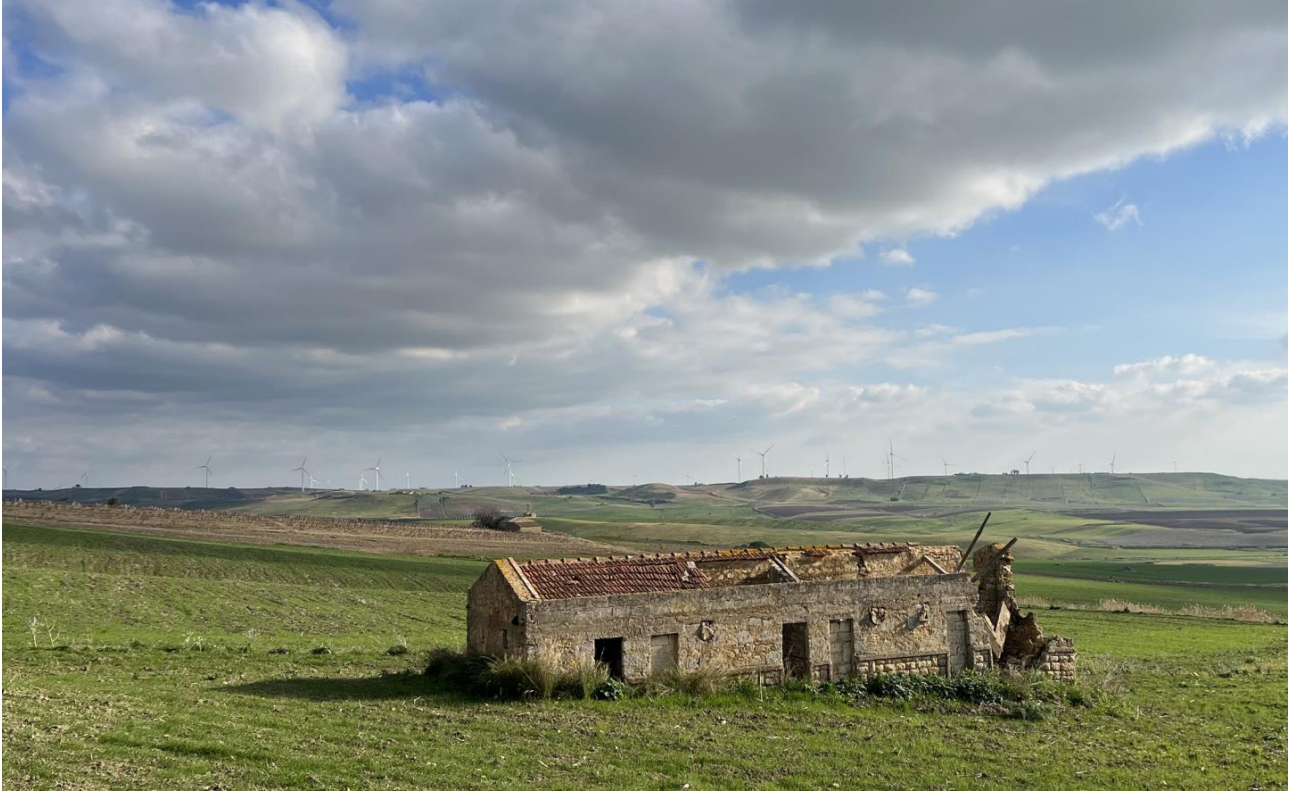
Figura 65 – Stato di fatto
