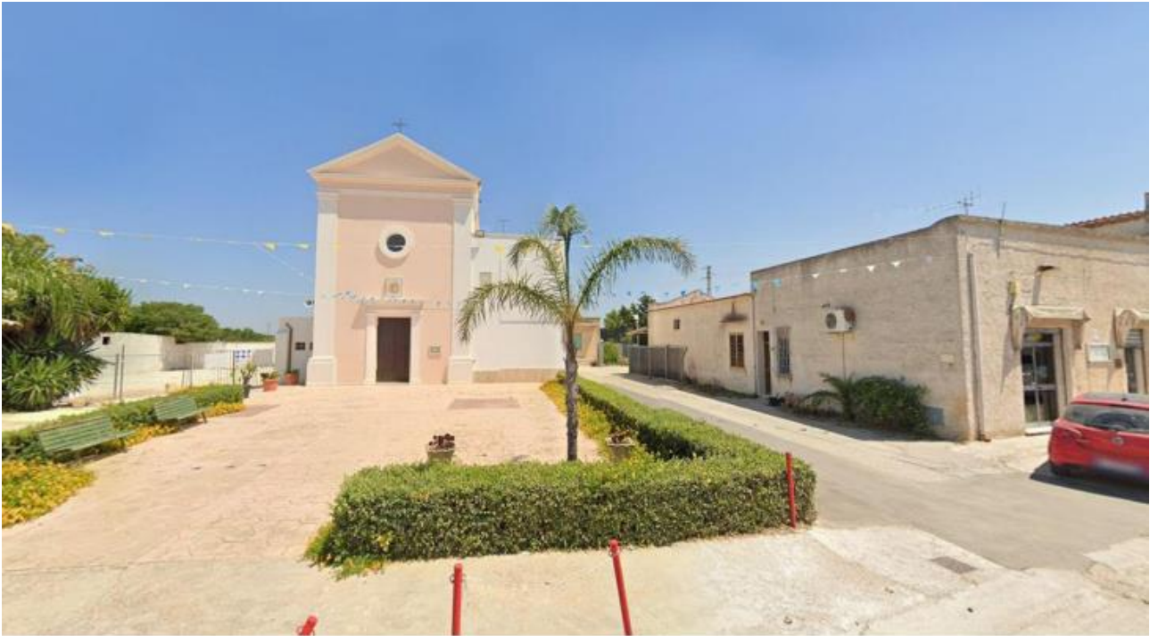
Figura 63 – Stato di fatto
