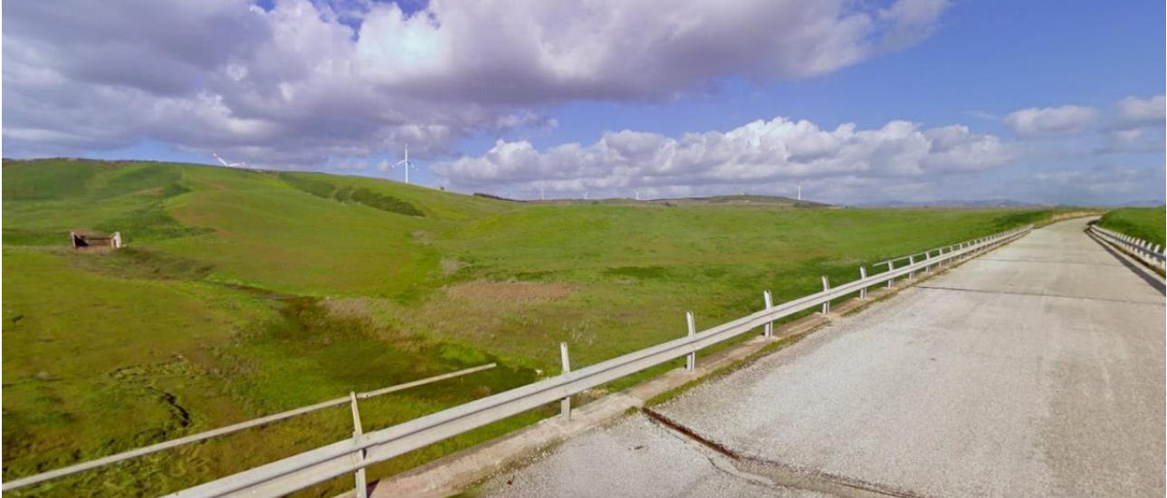
Figura 61 – Stato di fatto
