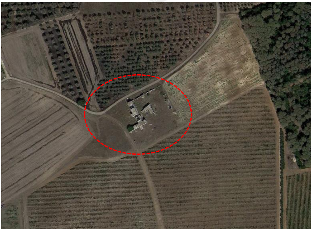
Figura 100: Masseria Casili (vista dall'alto Google Earth)
