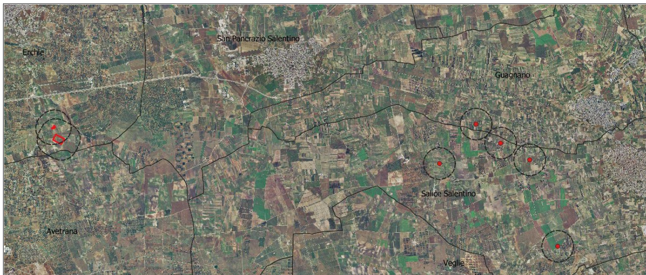
Figura 20 – In evidenza su ortofoto il posizionamento della sottostazione di servizio all'impianto in agro di Erchie (BR), rispetto all'ubicazione degli aerogeneratori.
