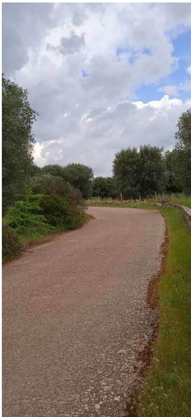
Fig. 44. Foto di un tratto della strada su cui sarà realizzato il cavidotto di connessione, nei pressi degli aerogeneratori WTG08-WTG09 .
