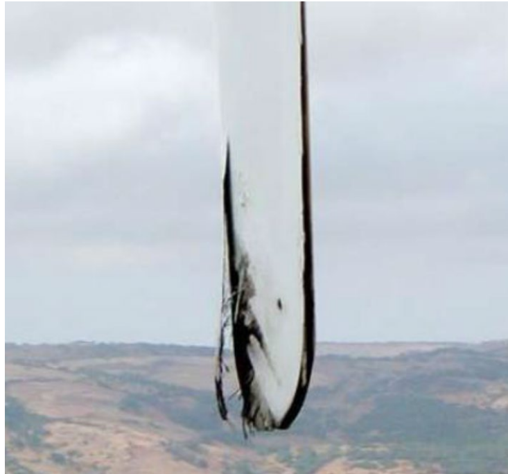
Figura 1 - Estremità della pala danneggiata da fulminazione atmosferica
