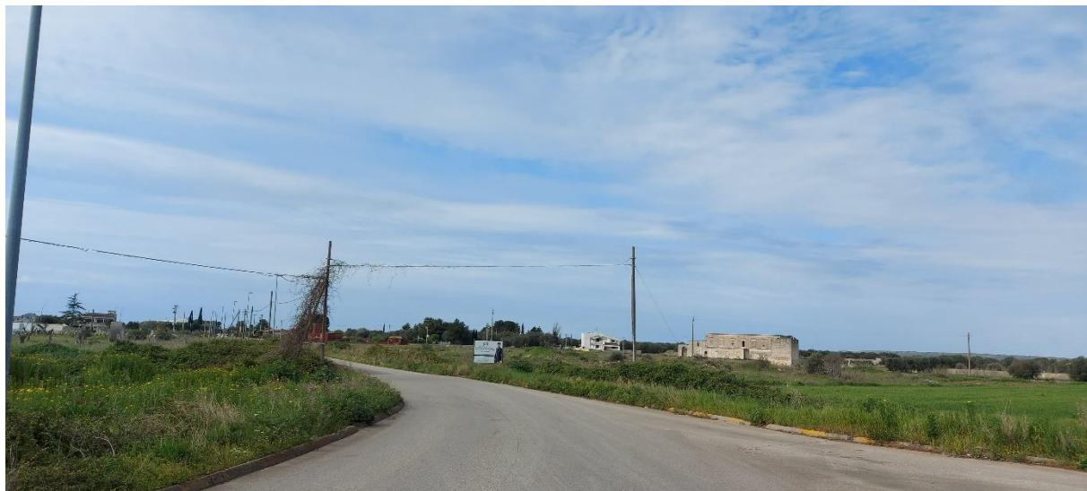
Stato di fatto – Punto di presa fotografica 1A
