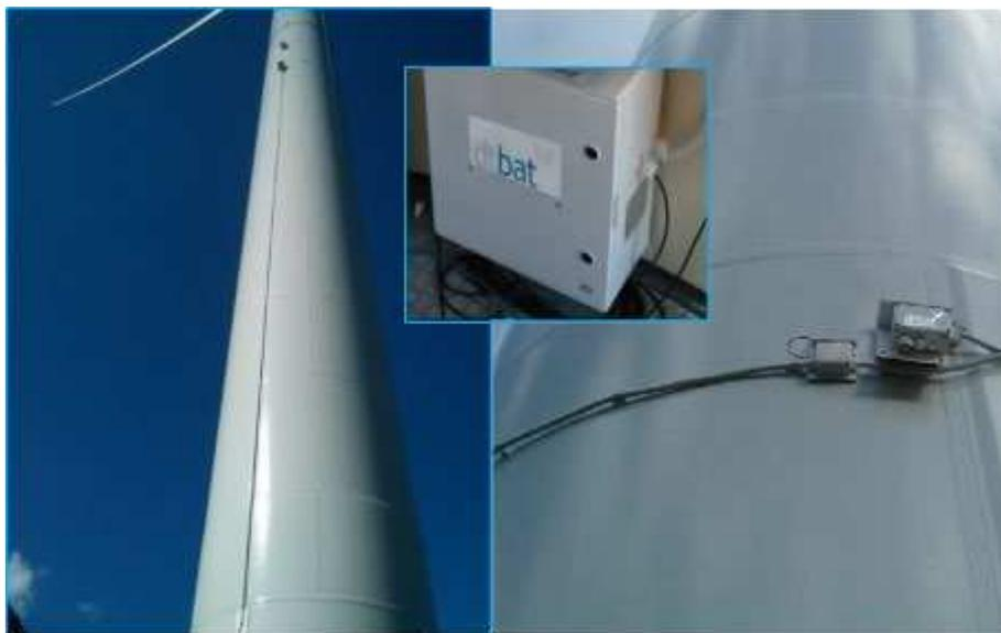
**Figura 3 – Esempio di installazione di un sistema automatico su aerogeneratore per abbassare il rischio collisione**
