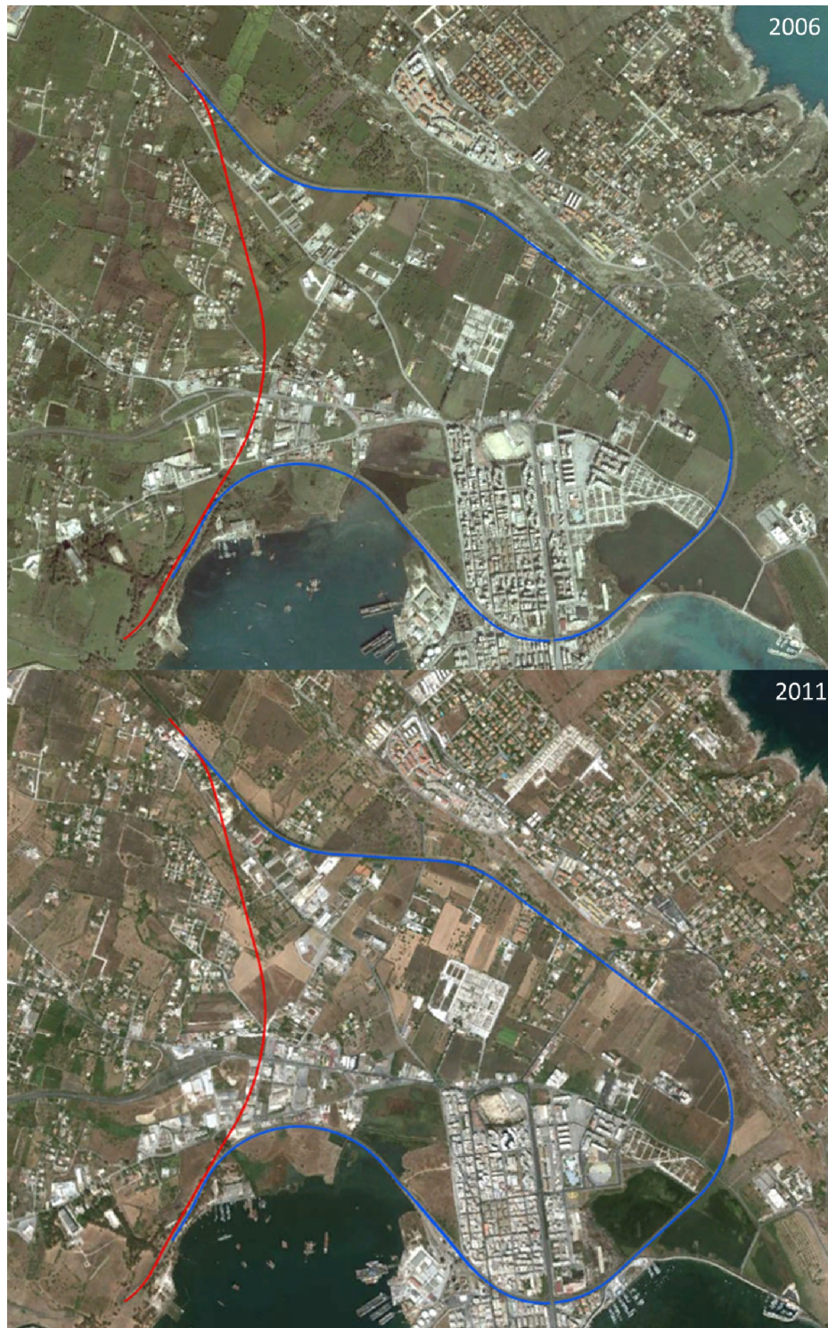
Figura 6-1 Vista aerea dell'area interessata dal progetto negli anni 2006 e 2011 (Fonte: Google Earth)
