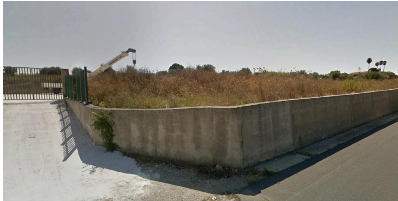
Figura 5-10 Aree di Cantiere Fisso AT.01 Ambito Piana Costiera
