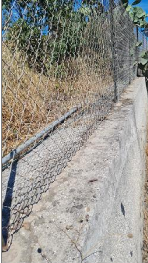
Figura 8 - Tubazione in testa a muro esistente
