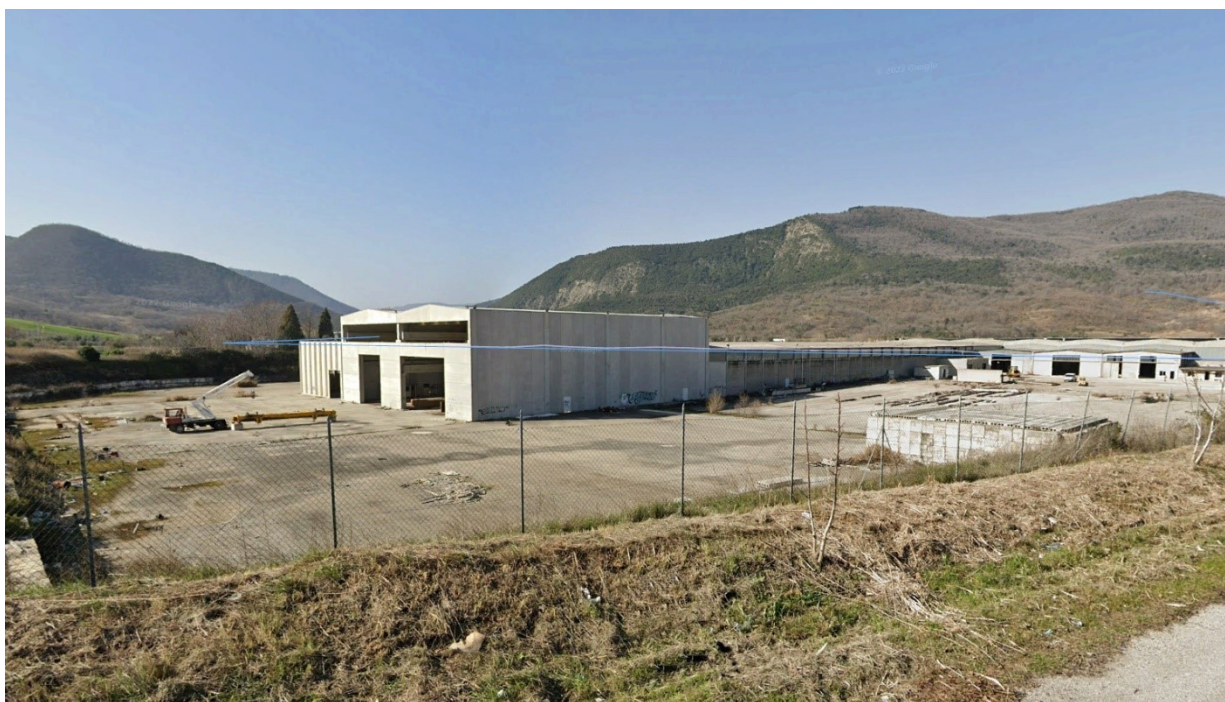
Figura 8 stabilimento industriale nei pressi del fiume Trigno, comune di Mafalda
