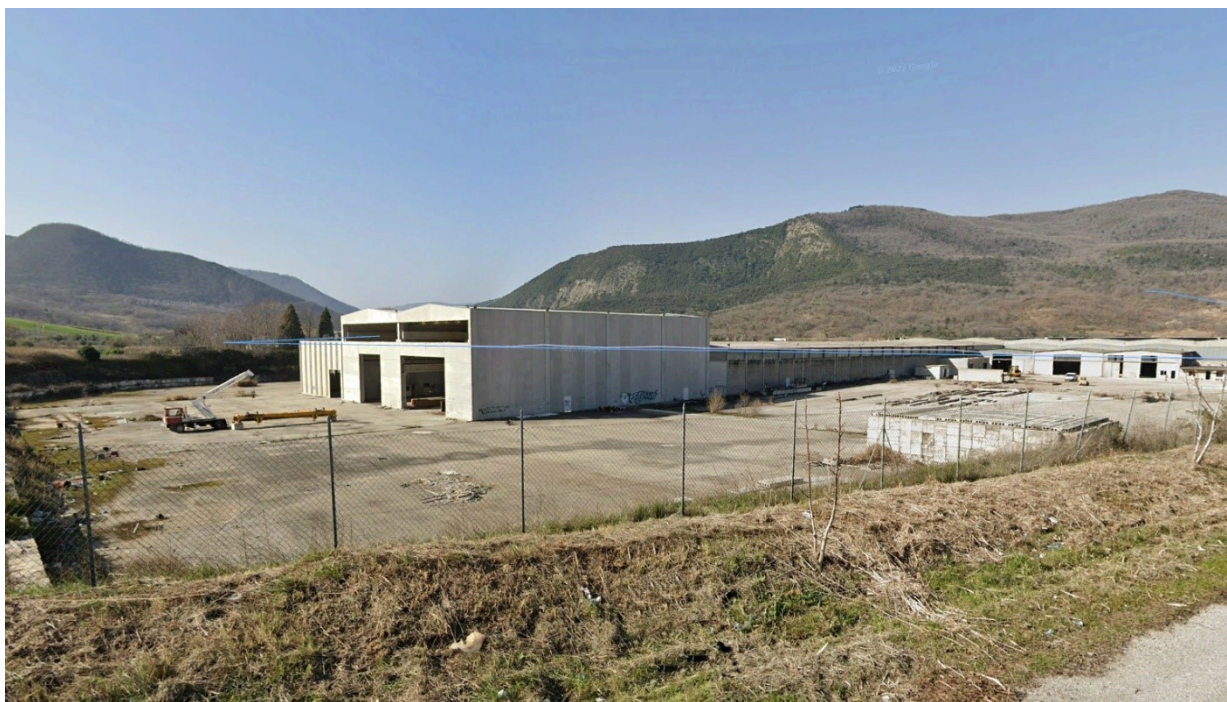
Figura 7 stabilimento industriale nei pressi del fiume Trigno, comune di Mafalda
